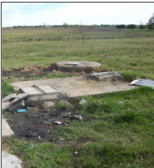
**Cámara séptica y pozo filtrante**
