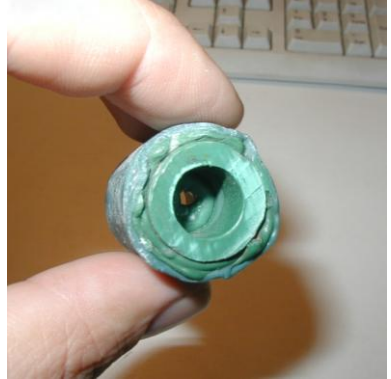
Fig. 1.5 c _ Estrangulamiento en polipropileno termofusionado.
