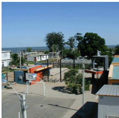
Fig. 6.1 a _ Edificación que elimina casi toda el área permeable del terreno.
