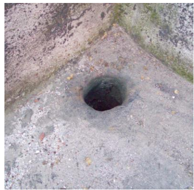
Fig. 6.3 d _ Desagües de pluviales limpio. (La colocación de un sombrerete ayudaría a evitar que entren elementos al interior del caño).
