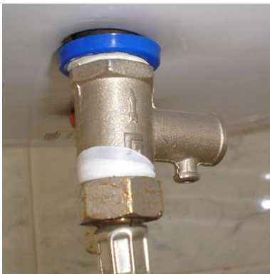
Fig. 4.1 a _ Válvula de seguridad del calefón
