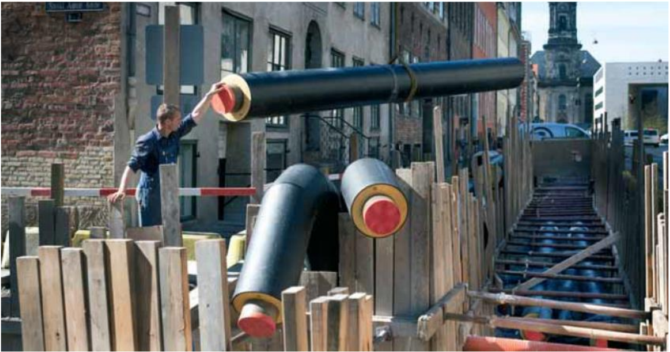
Figura 70 – Montaje de cañerías pre-aisladas para DH en Copenhague
