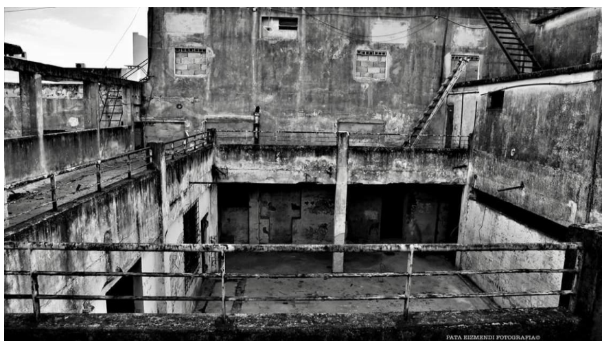
Foto: Pata Eizmendi – Ex cárcel de Cabildo
