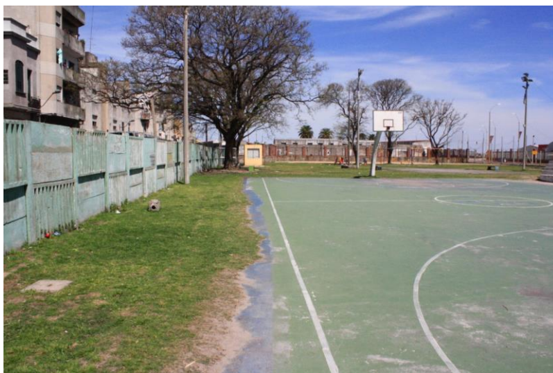
Figura 7. Estado de la Plaza de Deportes N°1 previo a su última re-inauguración.
