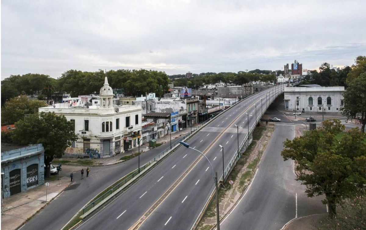
Viaducto del Paso Molino. Fuente: La Diaria , abril del 2020.
