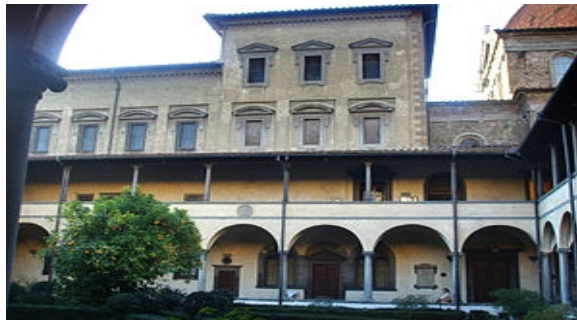
Figura 52. Imagen de la Fachada de la Biblioteca
