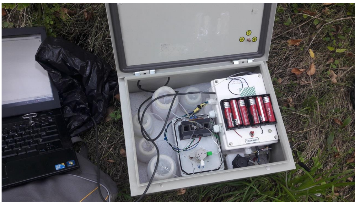
Figura 88: Momento de la instalación.
