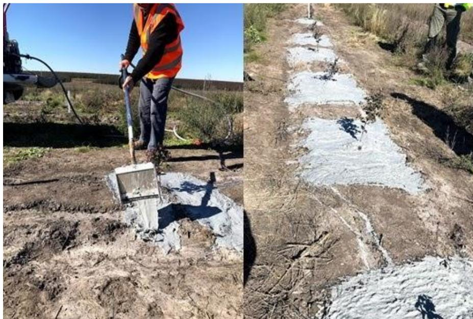
Figura No. 9. Equipo utilizado para la aplicación de Liquid mulch
