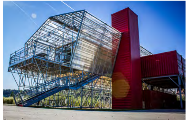
Les Grandes Tables de L'île, 300 m2 climatizados construidos a través de fibra de madera, contenedores, andamios; 1024 Architectes.
