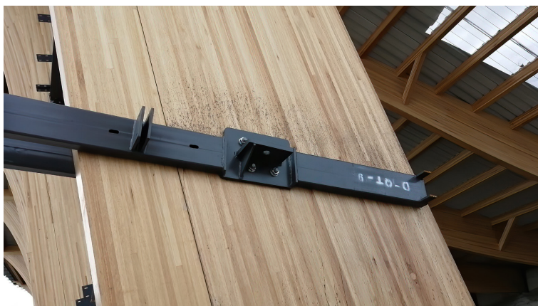
Figura 4.8. Fotografía de las manchas negras detectadas en uno de los pilares
