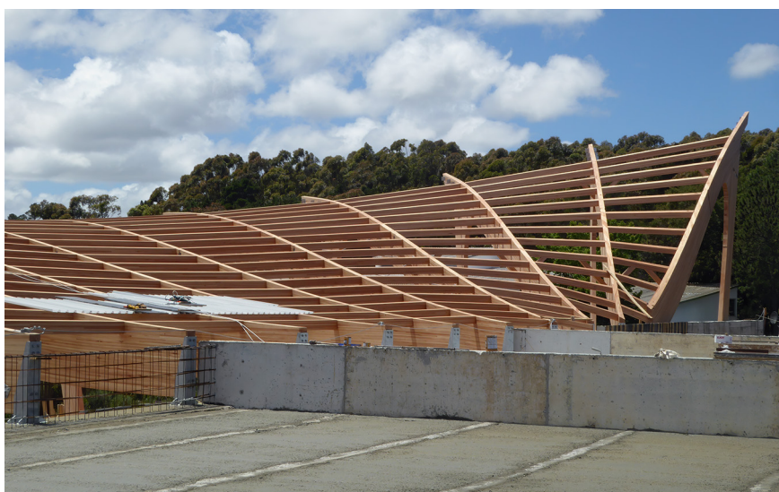
Figura A.8. Vista de la cubierta de la sala de esculturas desde la losa de techo de la sala de pinturas
