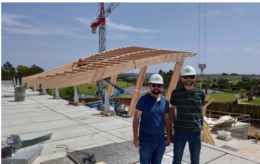
Figura A.7. Carlos Mazzey y Leandro Domenech en la losa de techo de la sala de pinturas; al fondo, la estructura de la sala de esculturas
