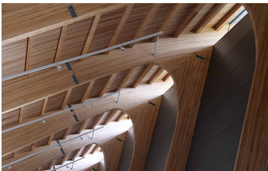
Figura A.21. Curvatura de los pórticos y entrada de luz desde las ventanas superiores, colocadas fundamentalmente por razones estéticas
