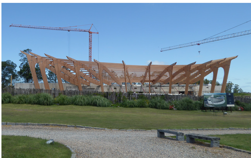
Figura A.10. Vista de la estructura desde el desde el parque de esculturas de la Fundación Pablo Atchugarry; se observa el cartel de obra
