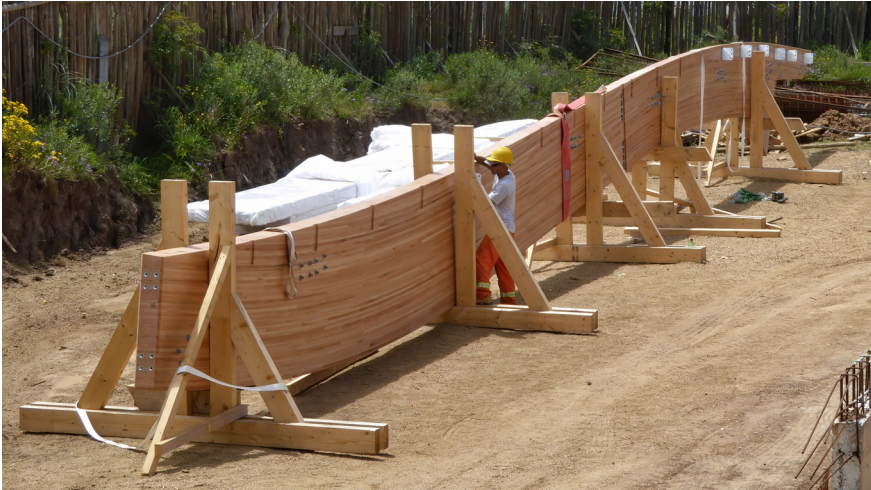
Figura 4.3. Fotografía del ensamblado de la viga del pórtico 11
