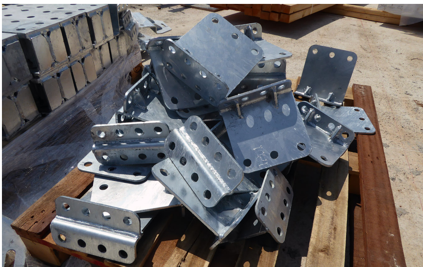
Figura A.6. Acopio de herrajes de correas y correas-riostra; se observa como todos son distintos y tienen un quiebre en la chapa en contacto con las vigas
