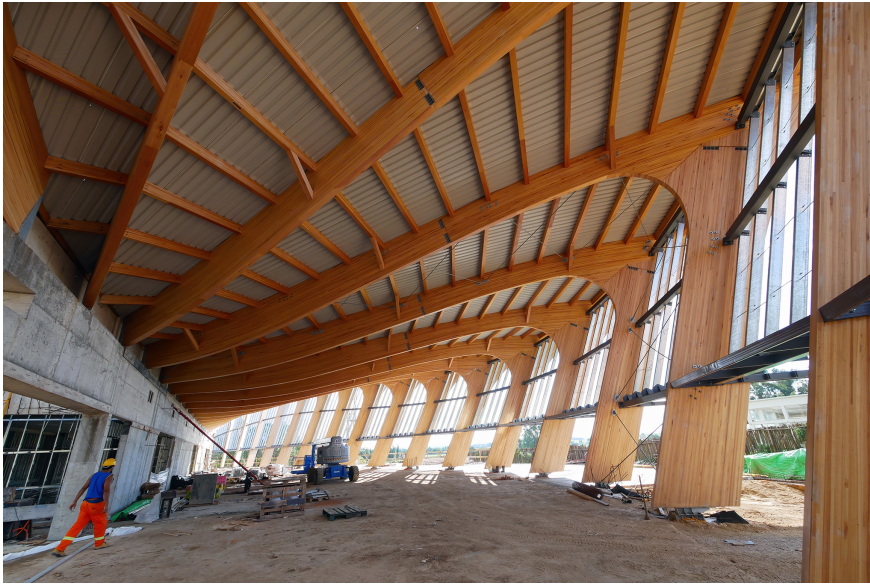
Figura 2.6. Fotografía de la estructura durante la construcción, donde se aprecia la distribución de correas de los pórticos 12 a 18
