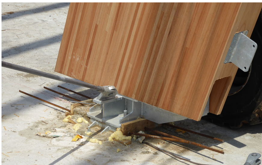
Figura A.3. Detalle de herraje y anclaje de uno de los pilares; se observa un herraje en forma de «T» para recibir el pilar no estructural
