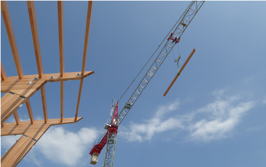
Figura A.4. Izaje de una correa de MLE mediante una grúa pluma
