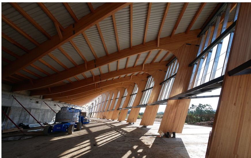
Figura A.15. Vista interior de la estructura luego de colocada la estructura metálica de fachada complementaria
