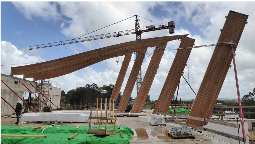
Figura 4.4. Fotografía de los pórticos 8 a 10 ya montados y de los pilares de los pórticos 11 y 12 presentados y apuntalados
