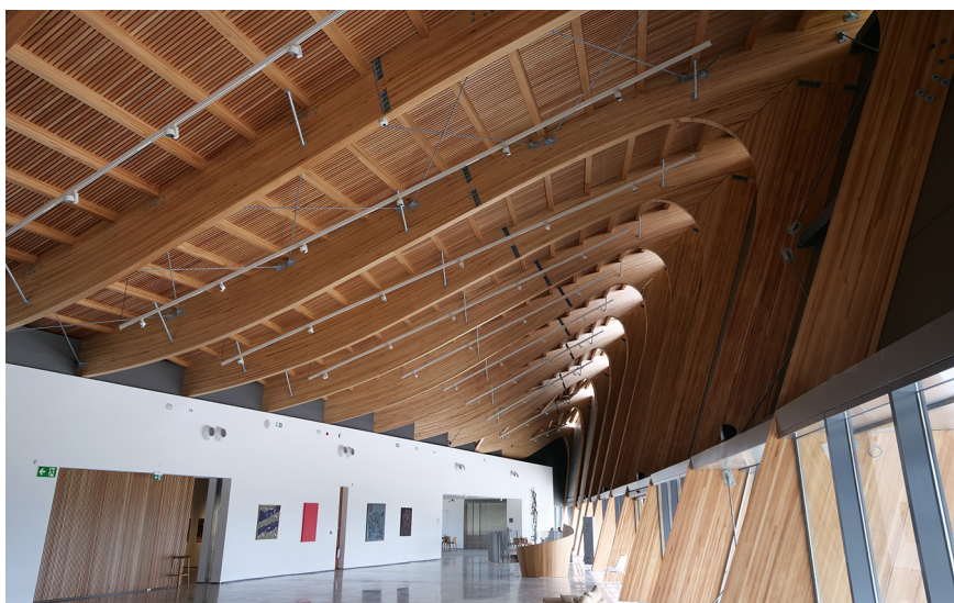
Figura A.24. Curvatura de los primeros pórticos; al fondo se observa el acceso a la cafetería
