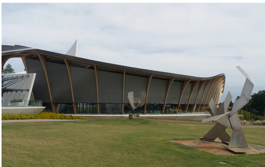
Figura A.25. Vista exterior de la estructura desde el parque de esculturas de la Fundación Pablo Atchugarry
