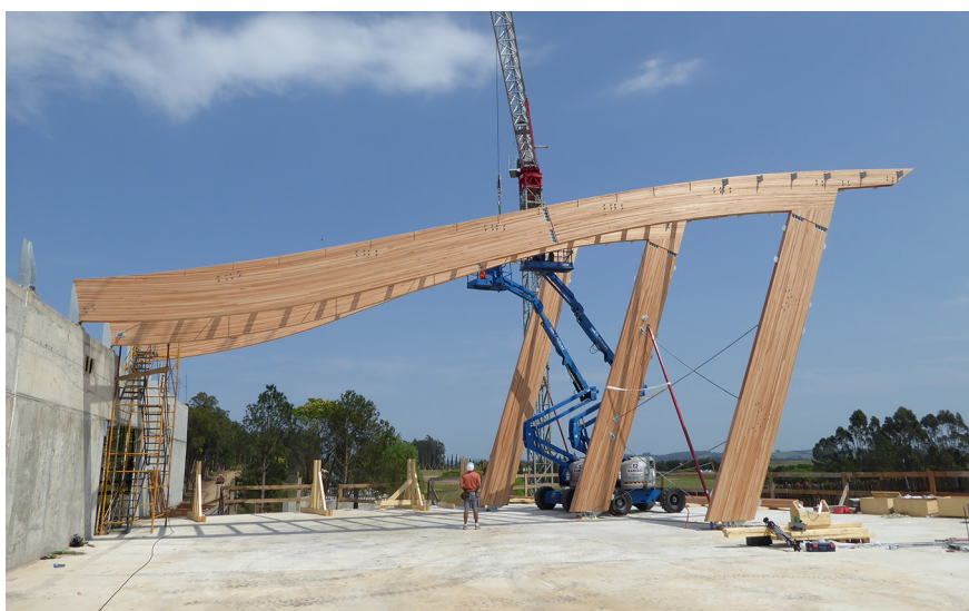
Figura A.2. Montaje de una correa de MLE entre los primeros pórticos colocados
