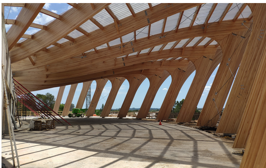
Figura A.11. Vista interior de la estructura en el comienzo de la colocación del techo
