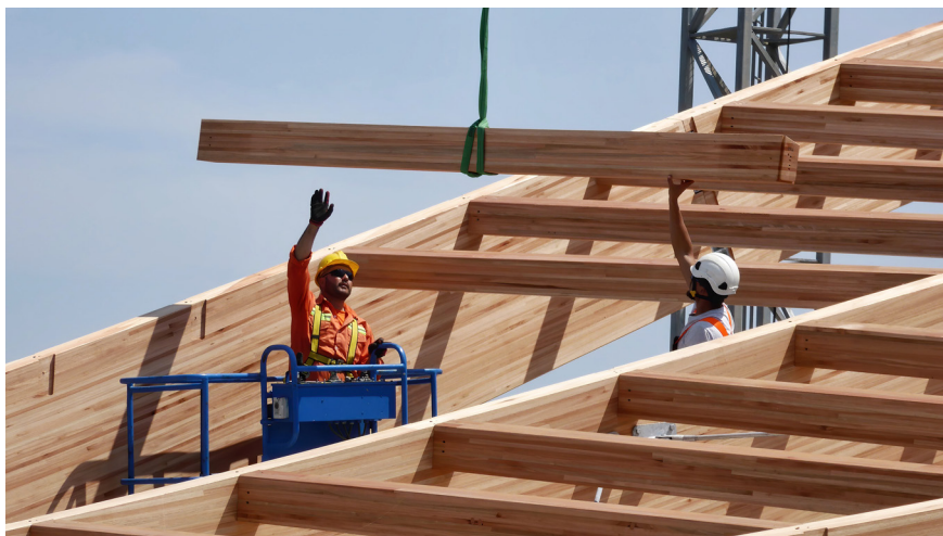
Figura 4.6. Fotografía de la colocación de las correas una vez armados los pórticos
