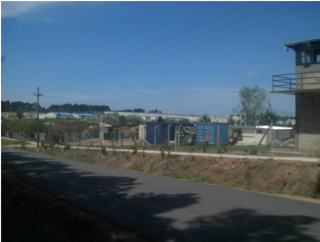
Fig.46 Entrada cárcel de Punta de Rieles. El pozo no pudo ser monitoreado por permanente uso de bomba y sistema de cañería a tanques de abastecimiento.
