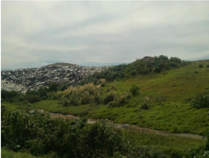
Fig. 74 Pala mecánica sobre pila de basura en vertedero y curso hídrico aledaño. Cno. Cepeda esq. Felipe Cardoso.
