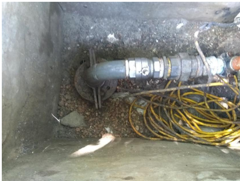
Fig. 69 Pozo con tapa hermética, sin losa sanitaria y gran cantidad de cables en la toma de agua. Complejo deportivo Devoto, Club Náutico. Se espera extraer muestra hídrica.
