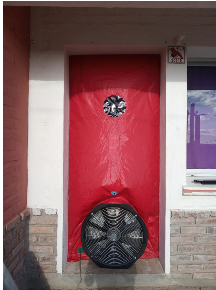
Figura 6.2: Blower door instalada en la puerta de entrada.
