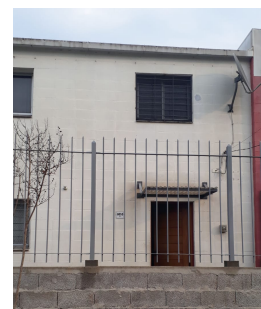
(b) Fachada frontal (norte)
