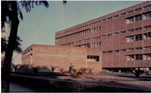
Figura 54. Jefatura de Policia de Salto (1959-1963) de Rodríguez Juanotena para el Ministerio de Obras Públicas. Fuente: SMA (FADU, UdelaR).
