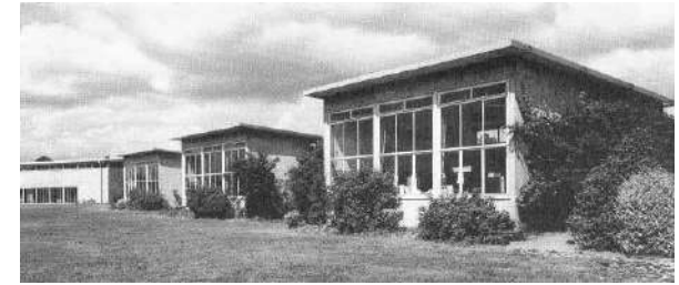
Figura 40. Escuela escuela primaria e infantil Cheshunt en Hertfordshire, Inglaterra (1948), de C.H. Aslin. Fuente: Saint, 1987, p.70.
