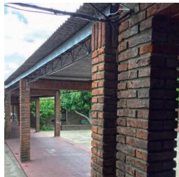
Figura 60. Vigas de varilla de acero en aula y galería exterior de la escuela 8 de San Carlos, Maldonado, versión D1. Fuente: fotografía del autor, 2018.
