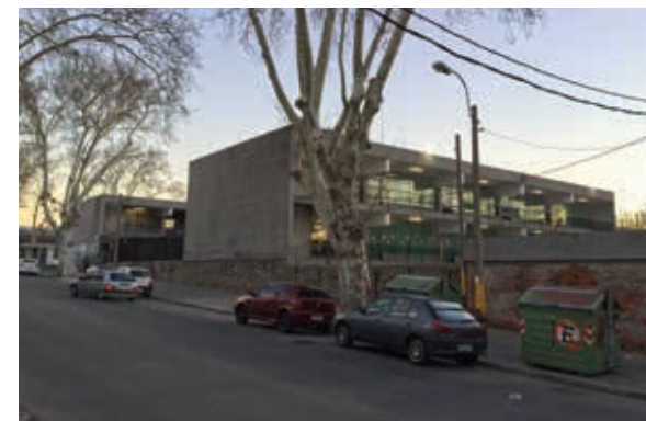
Figura 3. Escuela 33/66/84 de Montevideo (1962). Proyecto con dos pabellones de aulas de dos niveles, sin corredores entre salones, considerado entre los proyectos especiales realizados a partir del Aula Integral. Fuente: fotografía del autor.
