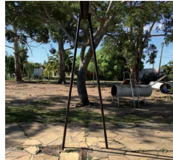
Figura 58. Apoyo en «V» invertida en Escuela 67 de Montes, Canelones, aula versión A. Fuente: fotografía del autor, 2020.
