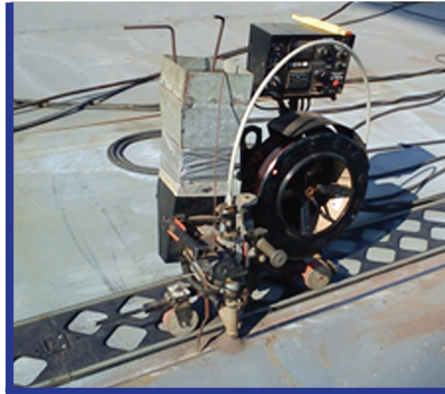
Fig. 12. Soldadura por arco sumergido.
