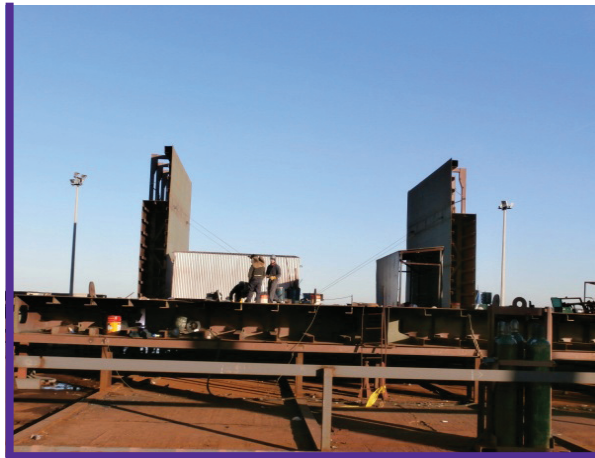
Fig. 6. Armado de bloques.
