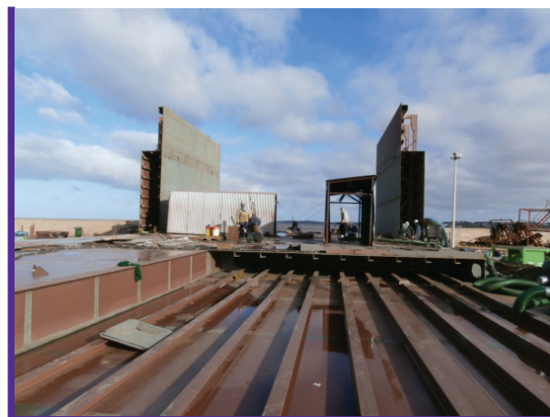
Fig. 5. Colocación de longitudinales.
