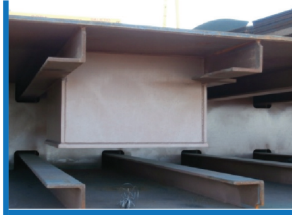
Fig. 24. Pocete de evacuación de agua en bodega.
