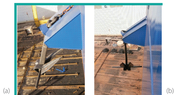
Fig. 28. Pruebas del ancla; (a) falla; (b) reparación.
