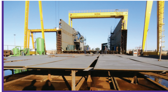
Fig. 4. Construcción del sub bloque A en el lugar.
