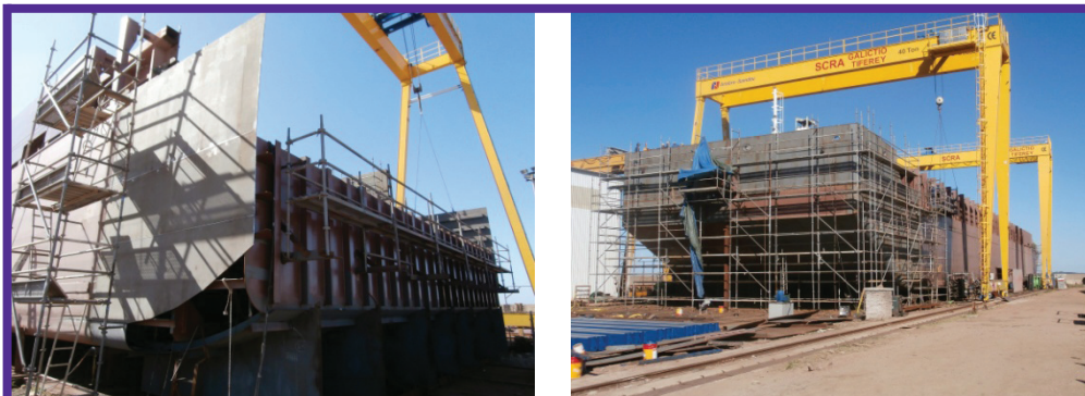
Fig. 9. Construcción de la proa.
