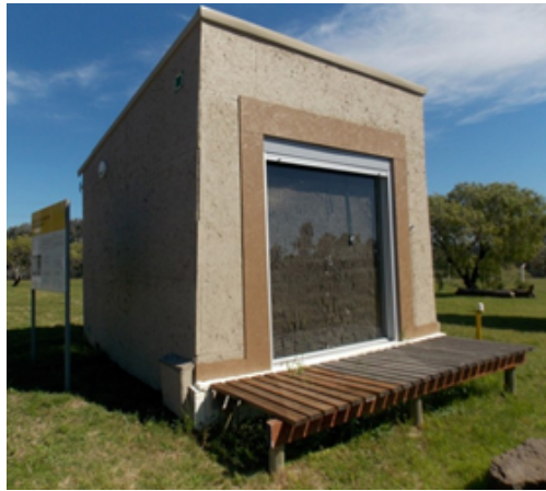
Figura 3.7: Foto del recinto con muro Trombe.
