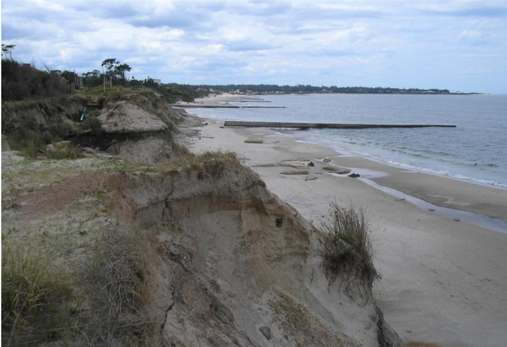
*Figura 24. Imagen que muestra la batería de espigones de Las Vegas. Obsérvese el descalce de los mismos hacia el agua. También puede apreciarse la exposición de la plataforma en algunos sectores*
