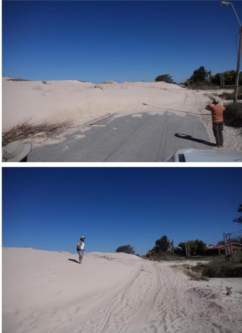
*Figura 14. Sedimentación dunar sobre rambla en Parque del Plata que impide el tránsito vehicular. Imagen de agosto de 2016*
