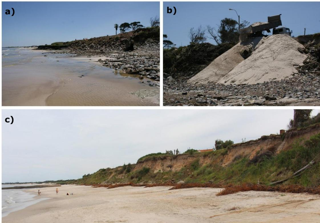
*Figura 9. Medidas de control de erosión costera. a) enrocado en la base del acantilado (noviembre 2012), b) volcado de arena al pie de acantilado (noviembre 2012), c) restos de ramas para retención de arena en la base del acantilado (diciembre 2015).*
