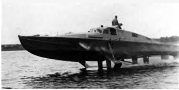
Figura 3.1.3: Embarcación utilizada durante la Segunda Guerra Mundial, Tietjens VS-7, desarrollada por Schertel.
