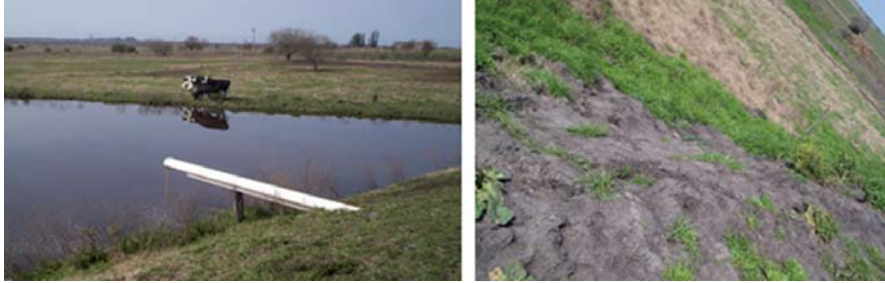
Figura 10- 10: Ganado utilizando la laguna para abrevadero debido a la falta de cercado (izquierda), infiltración a través de los taludes de la laguna (derecha)
