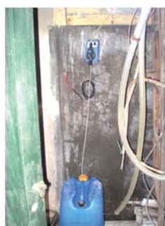
Figura 1- 7: Sistema de dosificación de hipoclorito típico en tambos (Fuente figura: CEPIS)
