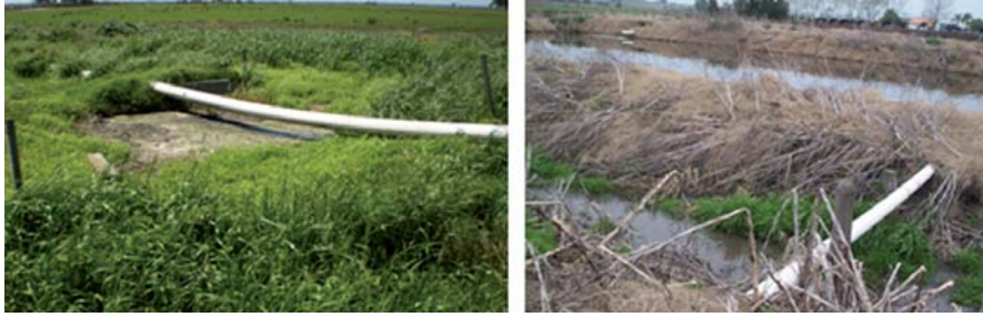
Figura 10- 9: Tuberías sobre unidades (izquierda), tuberías sobre cañadas (derecha)
