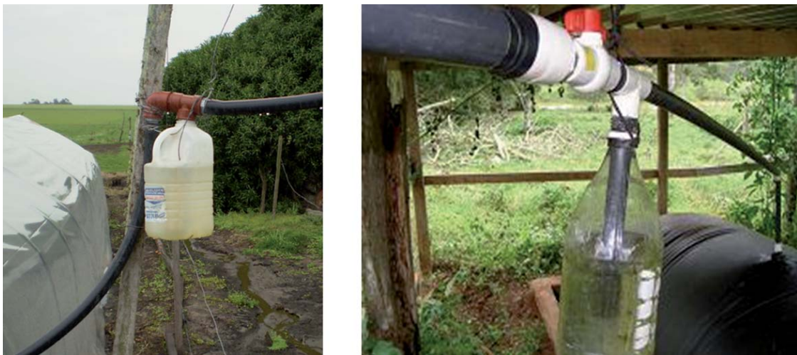
Figura 4- 12: Dispositivo de seguridad
