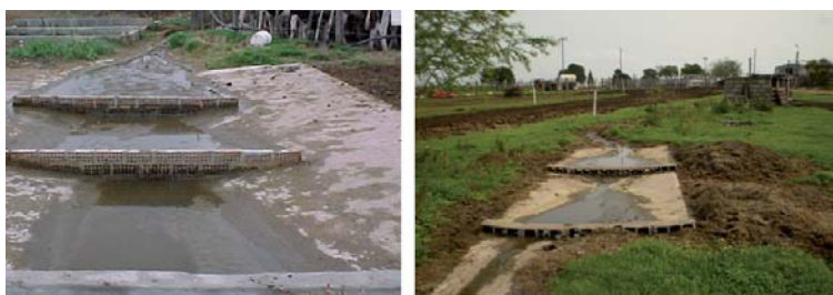
Figura 4- 2: Estercolero. Izquierda: grandes dimensiones limpieza con tractor. Derecha: pequeñas dimensiones limpieza con pala (menos de 100 vacas)
