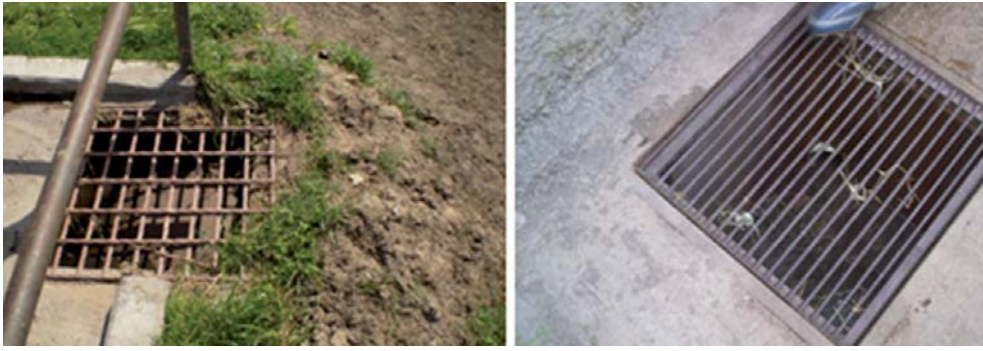
Figura 10- 13: Cámaras de retención de sólidos
