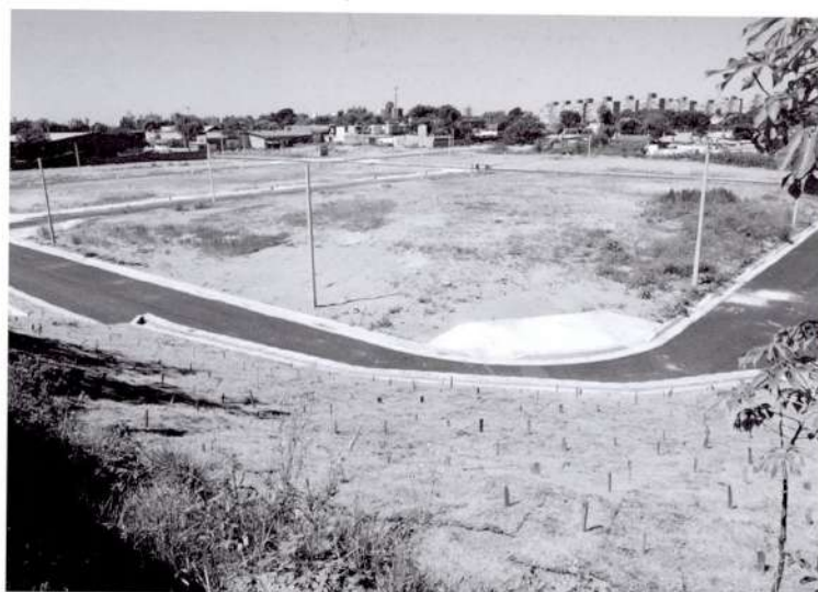
Obras de infraestructura en Capitán Duarte. Realojo del Asentamiento Isla de Gaspar. Fuente: Centro de Fotografía. IM
