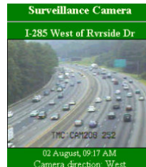
Figura 3-4. Vista de una cámara.
