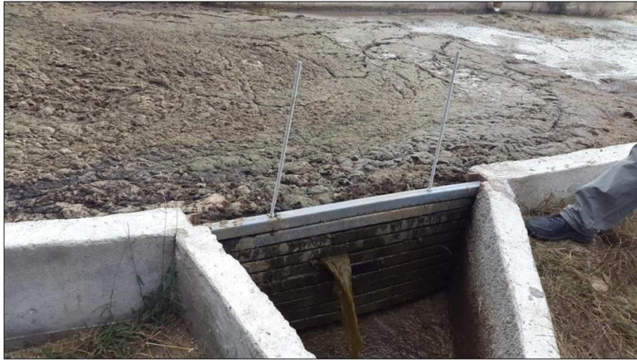
Figura No.7. Weeping wall en trampa de sólidos del tambo 3
