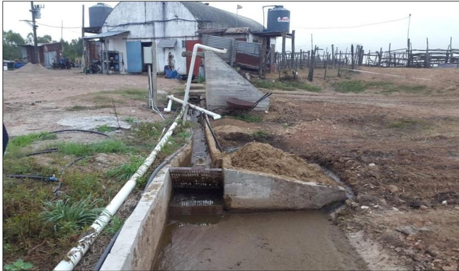
Figura No.2. Separación de sólidos pasiva del tambo 1
