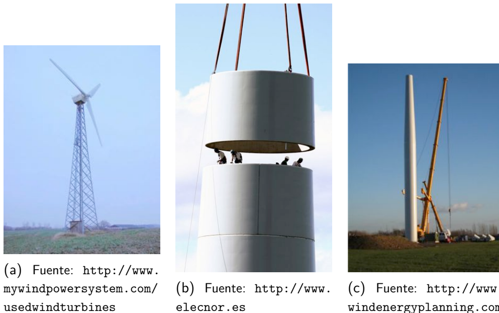
Figura D.4: Torre de aerogenerador.
