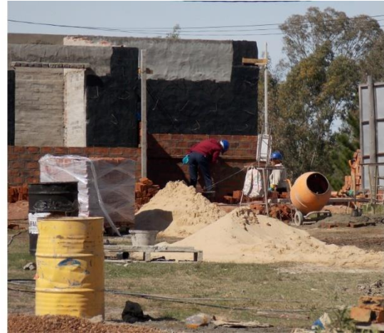
Imagen 8: Conformación de muros perimetrales.
