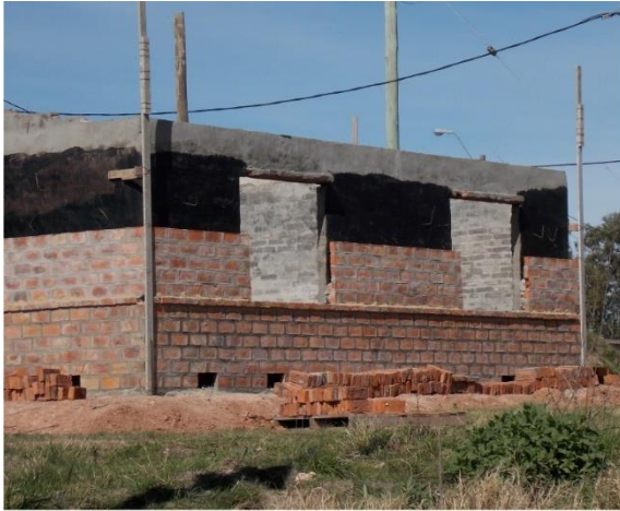
Imagen 7: Aplacado de muros
