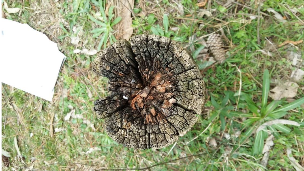
Figura 22. Poste atacado por hongos de la podredumbre marrón.
