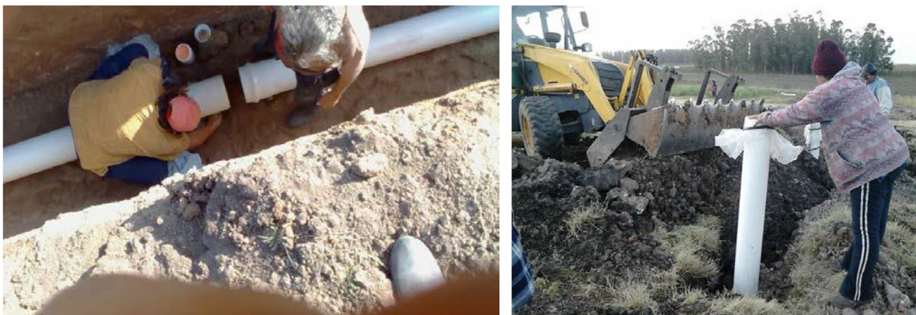
Trabajos de instalación de la cañería enterrada en el suelo, antes de la construcción del invernáculo, en el predio de Margaret Rocha. Junio de 2015.
