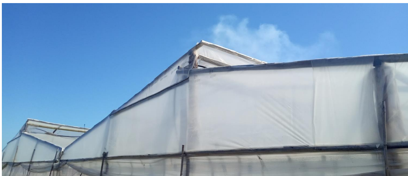
Fig. 13 Ventilaciones cenitales, invernáculo en Parada Viña, departamento de Salto.
