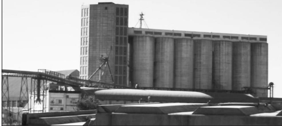
Figura 8. Conservación de granos. Silo de hormigón.
