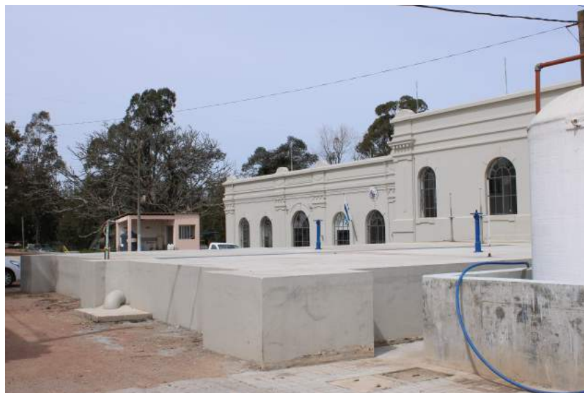
Figura 2.38: Depósito de agua tratada y tanque de contacto de cloro
