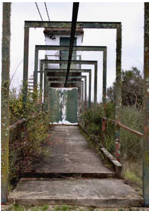
Figura 2.24: Obra de toma
