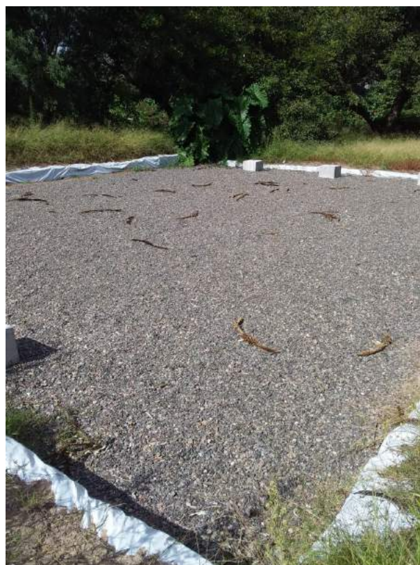
Figura 2.46: Explanada para geotubos.
