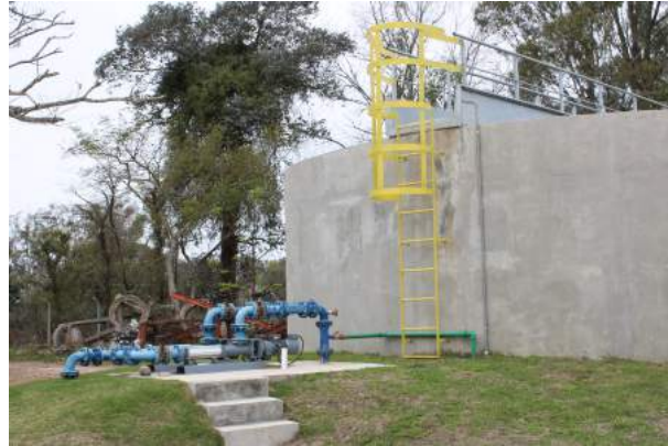
Figura 2.40: Tanque de espesado
