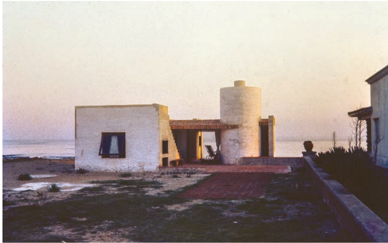
02. EXTERIOR. CONSTRUCCIÓN ORIGINAL. CAJA 14 DP0404
