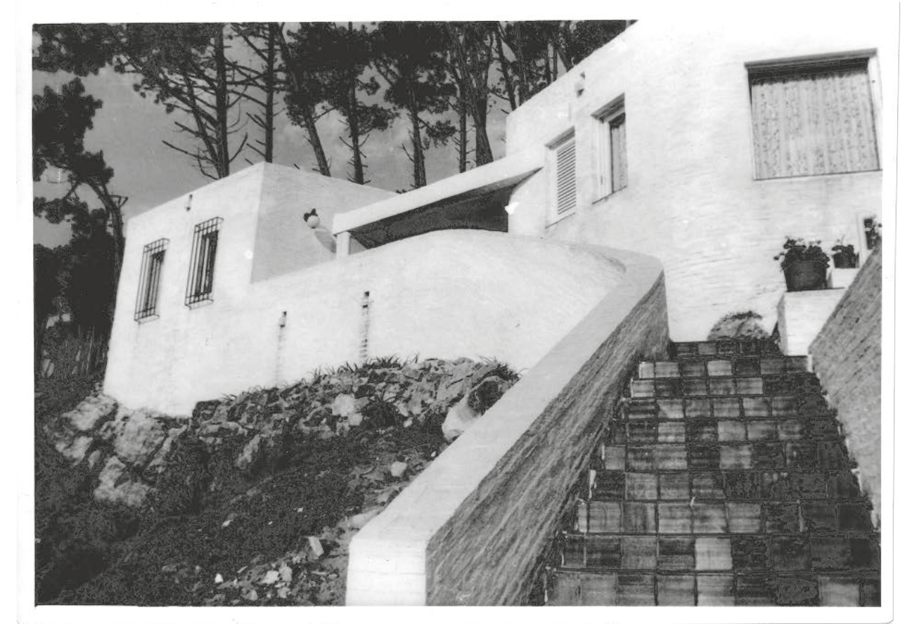
04. FOTOGRAFÍA EXTERIOR, FACHADA OESTE, CON LA ESCALERA DE BAJADA A LA PLAYA EN EL PRIMER PLANO. ESTADO ORIGINAL. BIBL.6 FT.20143
