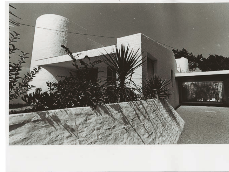
01 VISTA DE LA FACHADA PRINCIPAL DESDE EL ACCESO. BIBL.9 FT.20312
