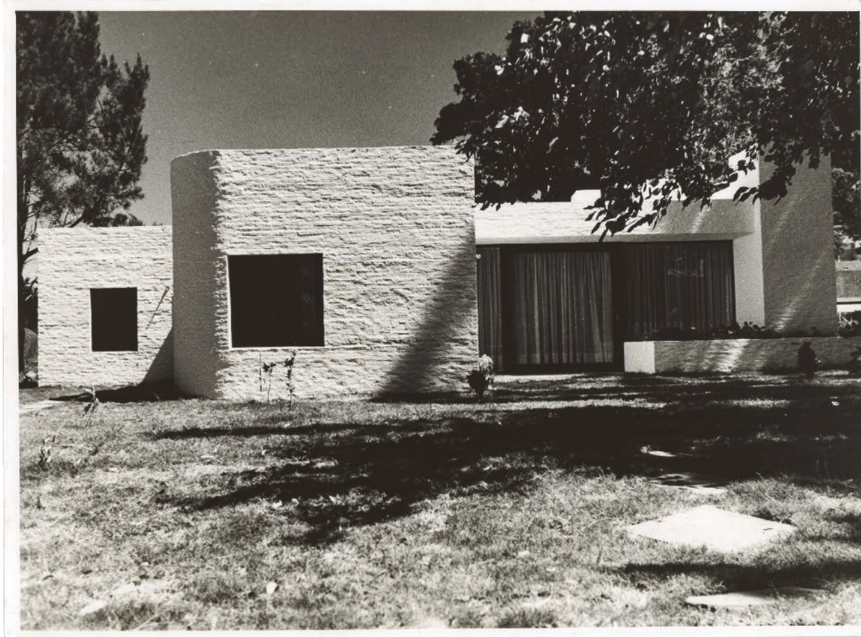
02. VISTA DE LA FACHADA DESDE EL SURESTE. BTO.15 FT.20888
