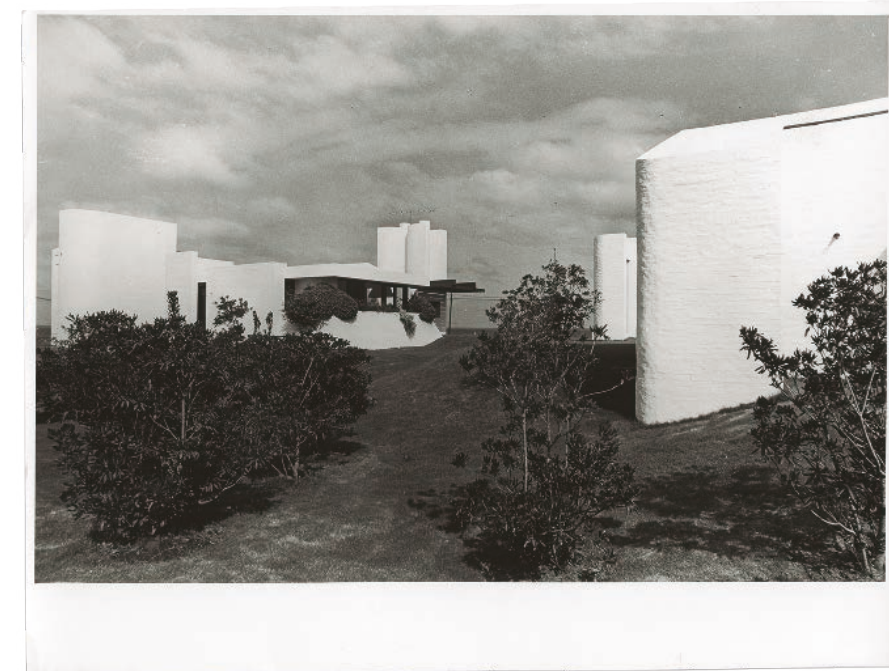
08. VISTA DE LA CASA 2 DESDE EL NOROESTE, EL INTERIOR DEL CONJUNTO. BTO.19 FT.21496
