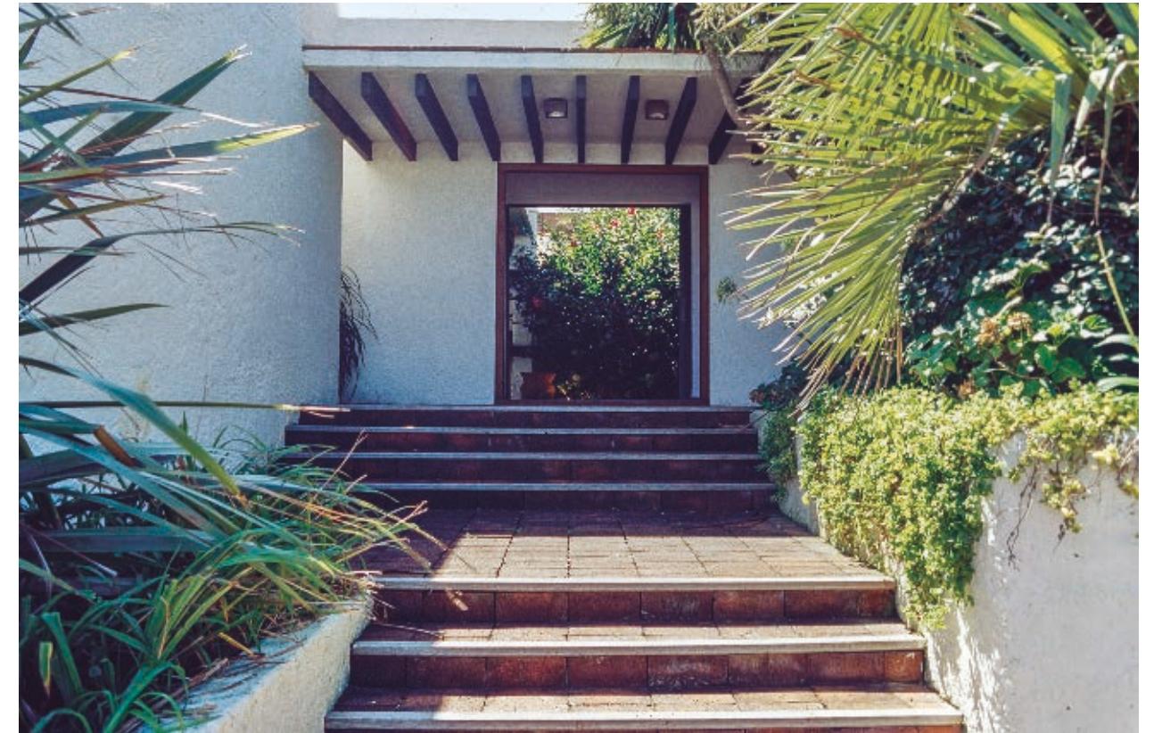
05. VISTA DEL ACCESO. CAJA 32; DP.0135
