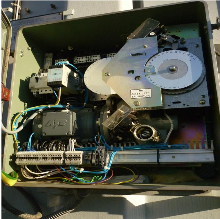
**Figura 3.6:** Regulador de transformador MK10
