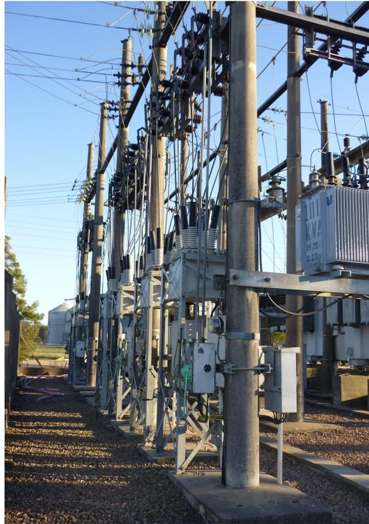
**Figura 3.3:** Celdas de salida en 15kV
