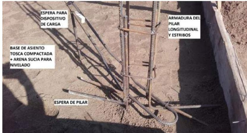
Figura 16 – Detalle del inicio de los pilares.
