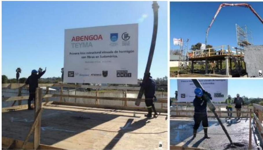
Figura 19 – Hormigonado de la losa elevada.
