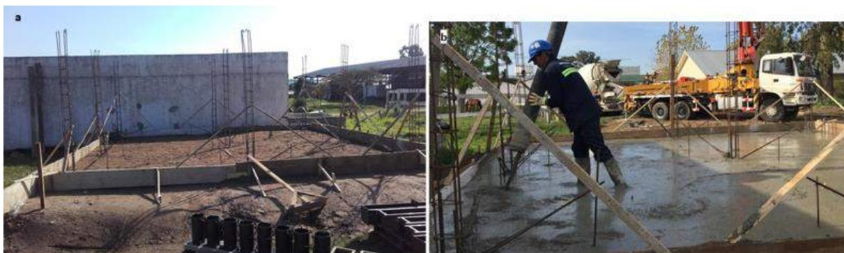
Figura 17 – Hormigonado de la losa de fundación.
