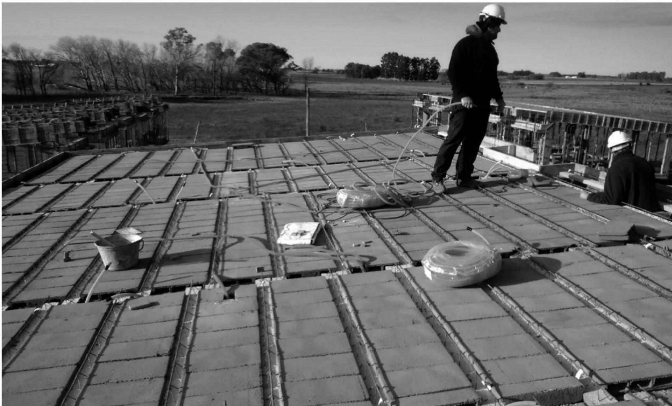
rubro hormigón y mampostería se desarrollan paralelamente, en este caso ello no fue posible, por lo que se debió culminar el hormigón armado antes de comenzar con el Steel Framing, ya que éste se sujeta a la estructura de hormigón; esto enlenteció la entrada de otros rubros asociados al levantamiento de muros, como ser el amure de aberturas, aislaciones térmicas y acústicas, instalaciones eléctricas y sanitarias.
