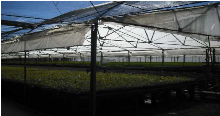
Figura 1: Imagen de las instalaciones del invernáculo.
