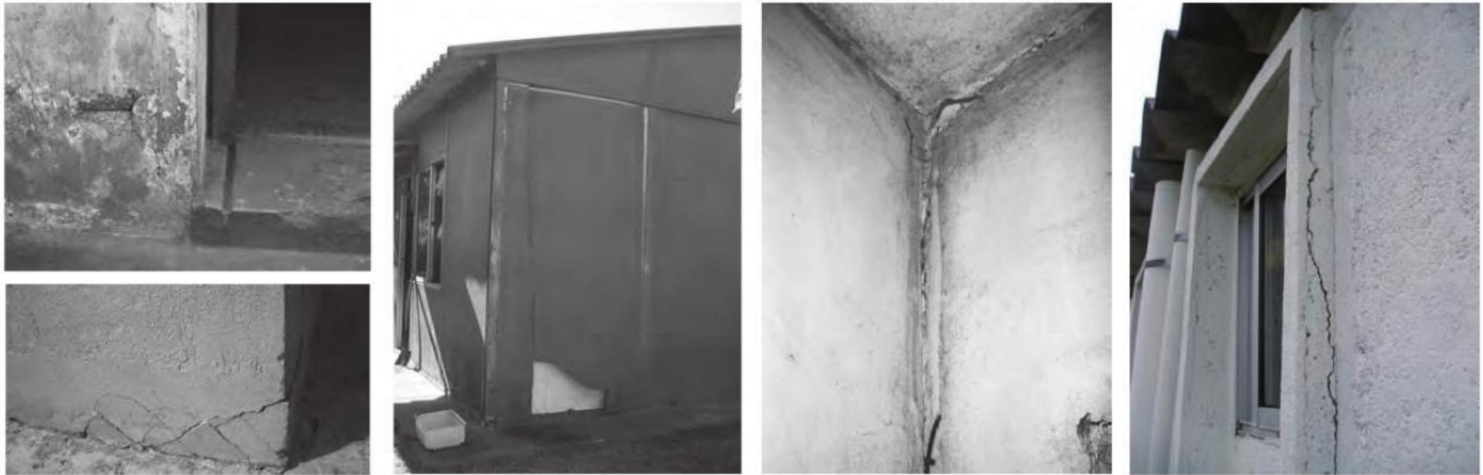
Desprendimiento de recubrimiento por corrosión de armaduras
