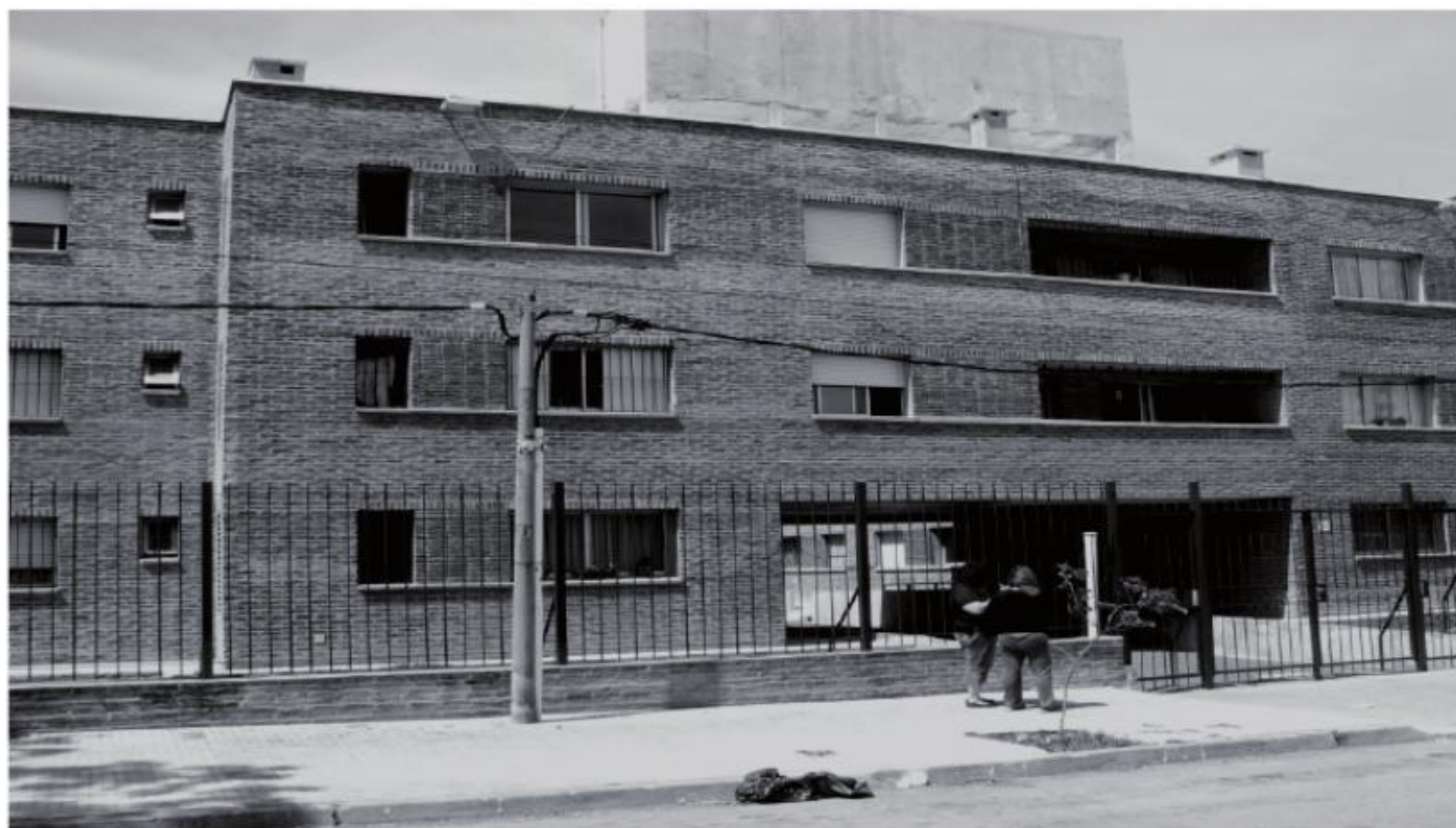
Edificio PETRONA VIERA (2009) cuenta con 36 viviendas y se encuentra localizado en Silvestre Pérez 2384
