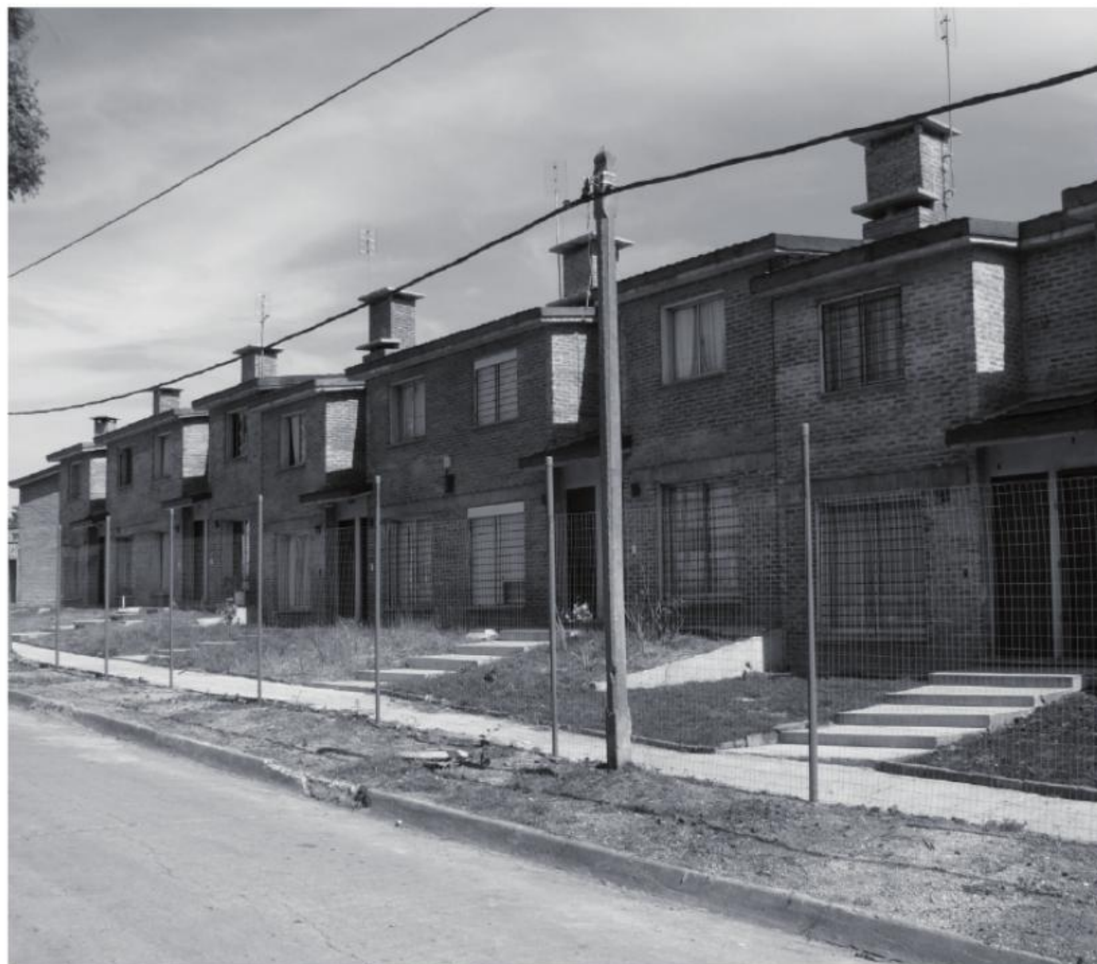
Cooperativa de Ayuda Mutua COVIPALMA (2010) con 36 viviendas se ubica en Victoriano Alvarez y Avda. Garzón.
