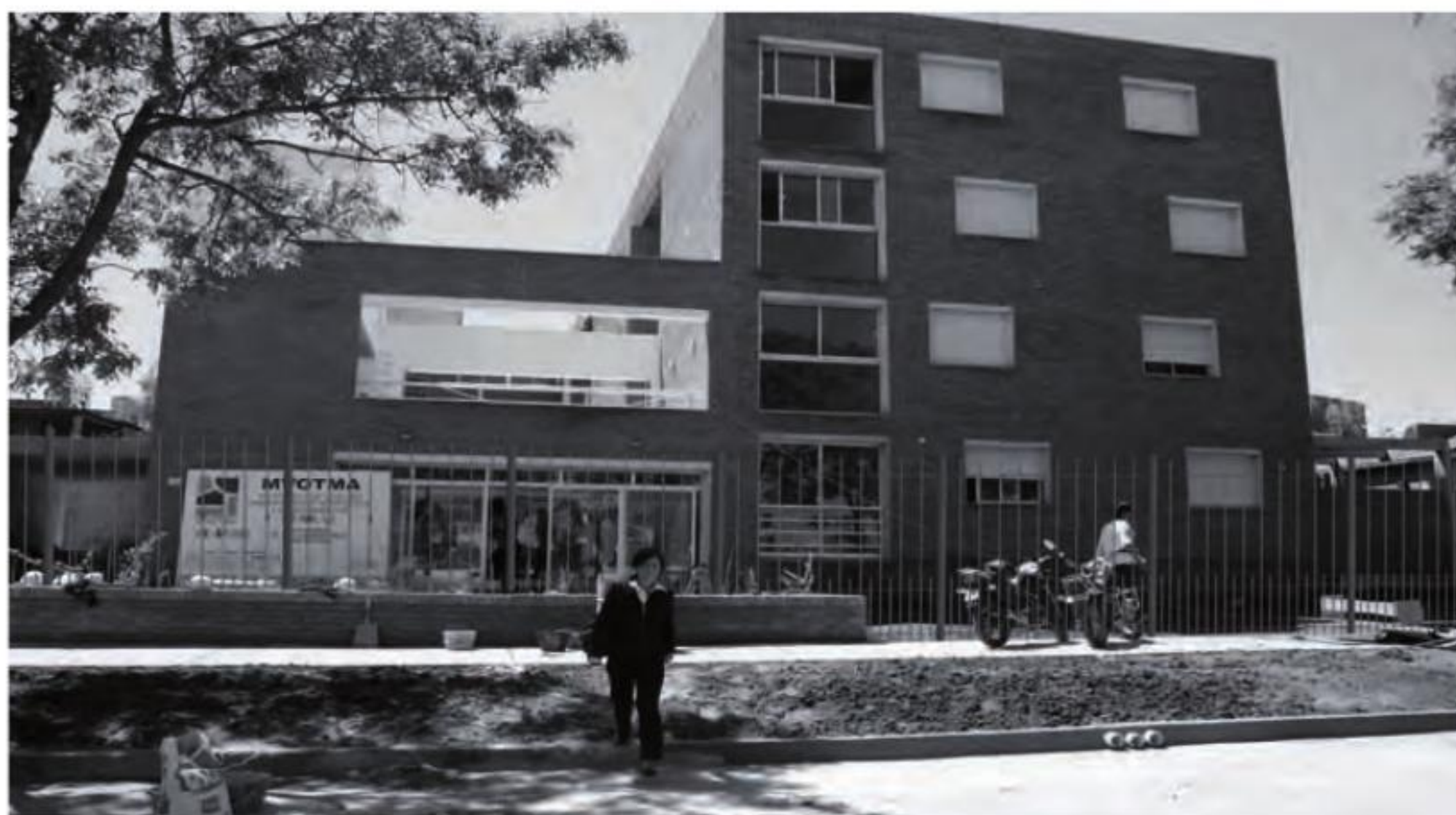
Edificio Rafael Barradas (2009) con 20 viviendas se encuentra ubicado en Tres Cerros y Avda. Italia.
