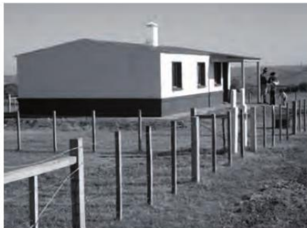
Obra de MEVIR
