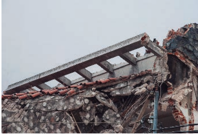
FIGURA 3. DEMOLICIÓN CASAS MARTIRENA DIGHIERO, 2011
