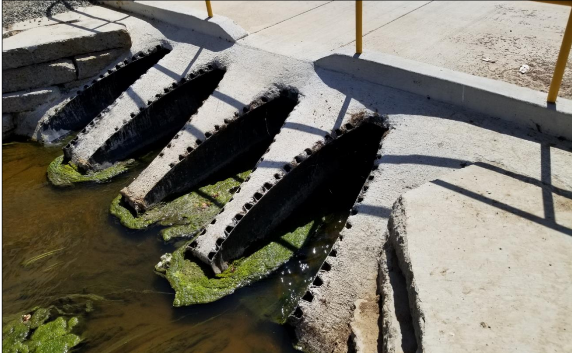
Figura 3.29: Alcantarilla tipo considerada en el modelo. (Foto: B.Pitton).
