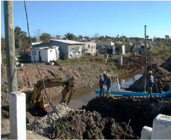
Inserción ex post de servicios de infraestructura - tarea impostergable
