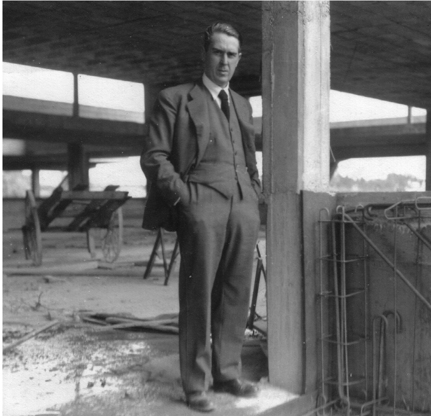
Carlos A. Surraco durante la construcción del Hospital de Clínicas. Archivo IHA.
