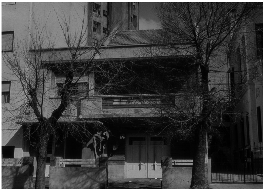
Vivienda Francisco Rocco. Arq. J. A. Rius, 1927. Foto: Archivo SMA.
