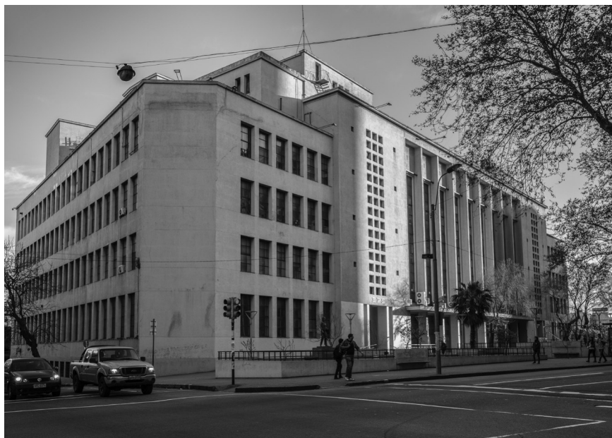
Banco de Previsión Social. Arqs. B. Arbeleche y M. Canale, 1937. Foto: Silvia Montero. SMA.
