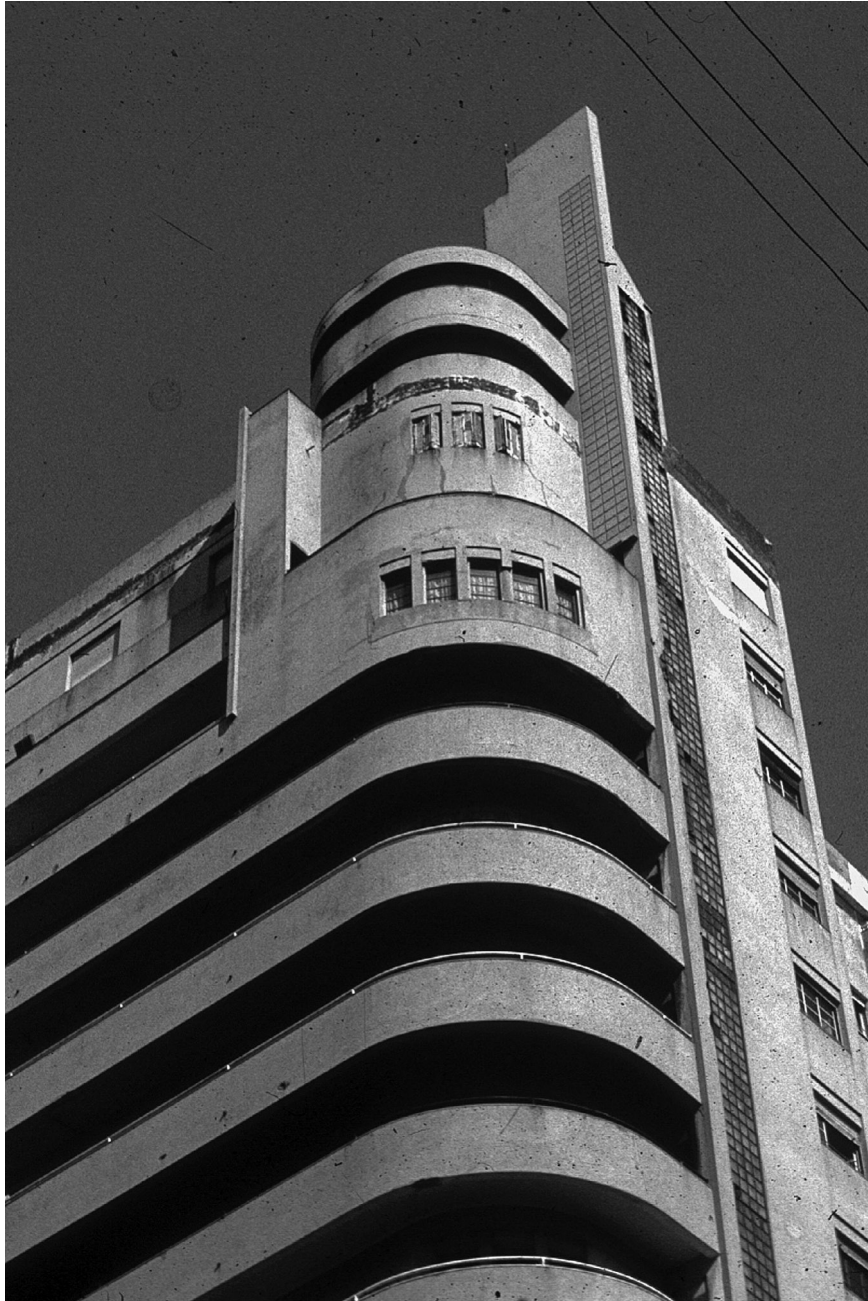
Edificio Lapido. Arqs. J. Aubriot y R. Valabrega, 1929-1933. Foto: Silvia Montero. SMA.
