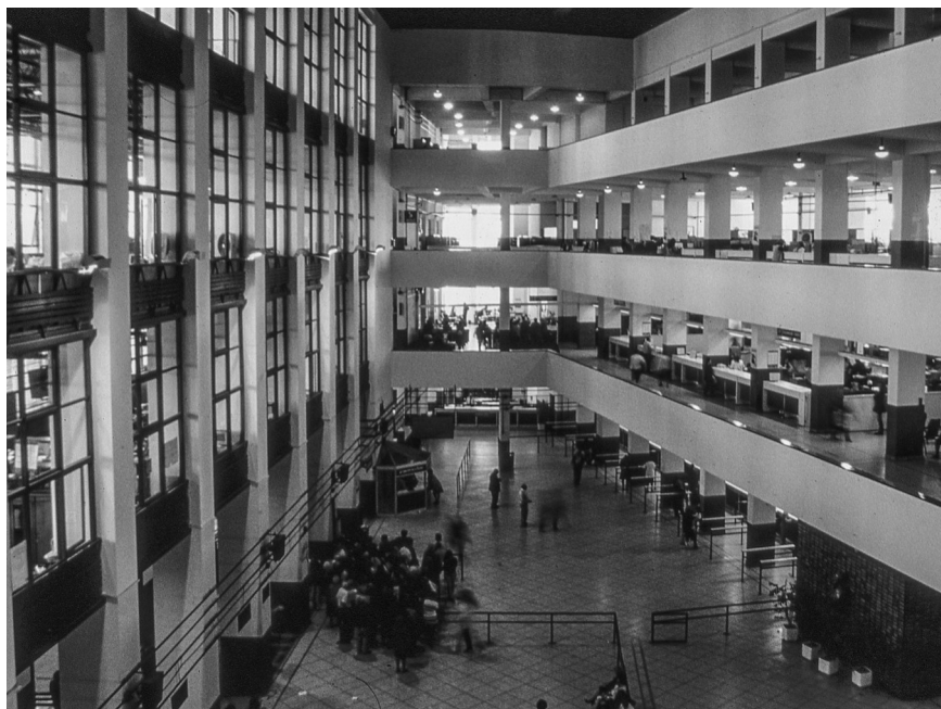
Banco de Previsión Social. Arqs. B. Arbeleche y M. Canale, 1937. Foto: Danaé Latchinián. SMA.
