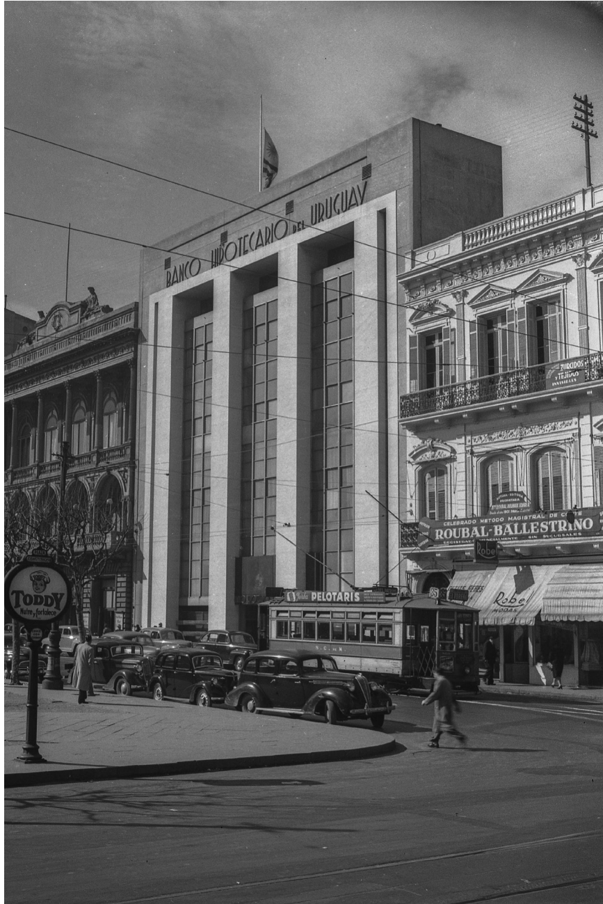
Banco Hipotecario. Actual BPS. Arq. J. Aubriot, 1936. Foto: Jeanne Mandello. Archivo IHA.
