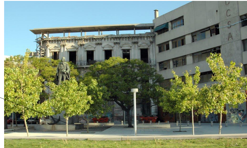
Fig 22 -Patio de Garibaldi, vista actual
