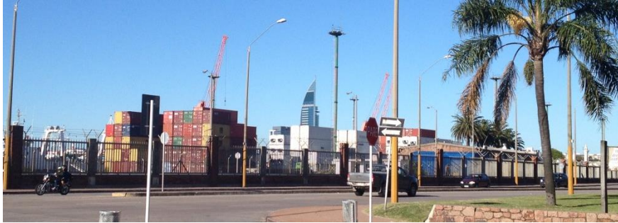
Fig. 35- Vistas lejanas, torre de las comunicaciones
