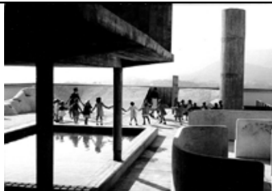
Le Corbusier, Kindergarten Unité d'habitation Marseille, 1947-52
