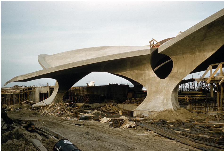
50 - Terminal TWA en obra.
