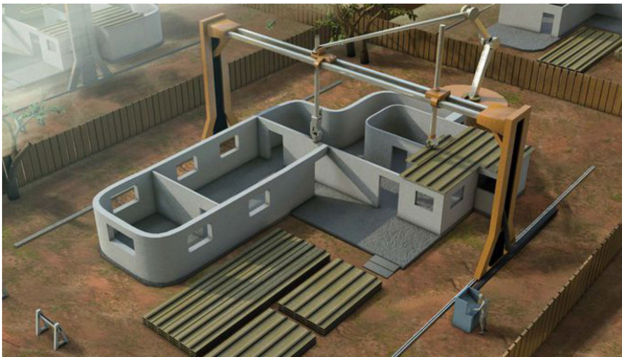
45. PRIMER CONCEPTO DE CONTOUR CRAFTING DE IMPRESIÓN EN CONCRETO.
