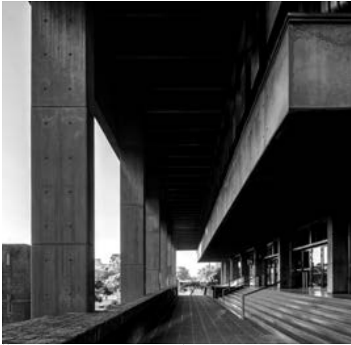
IMG 72. Toma fotográfica del espacio intermedio desde el nivel de la calle colonia. Se percibe la fuerte horizontalidad en la viga de borde del entrepiso y en la baranda de ladrillo, contrastando con la verticalidad de los pilares que recorren la triple altura. Fotografías de Marcos Guiponi
