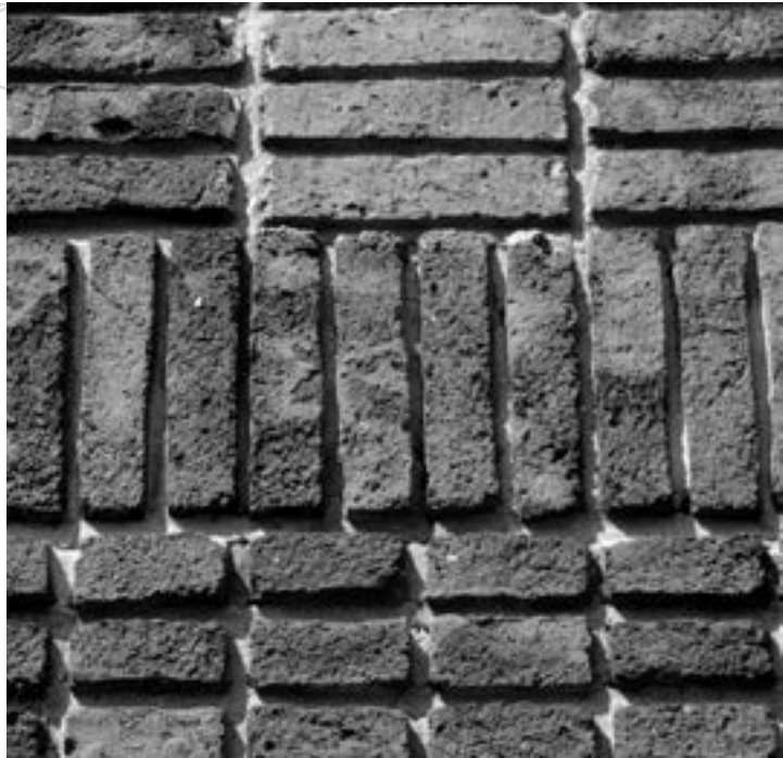
IMG 18. Detalle de fachada sobre calle Arenal Grande. Variación de texturas generadas por la forma de aparejo utilizada en la colocación del ladrillo de campo. Banco de Previsión Social. Fotografía Enrique Castro.
