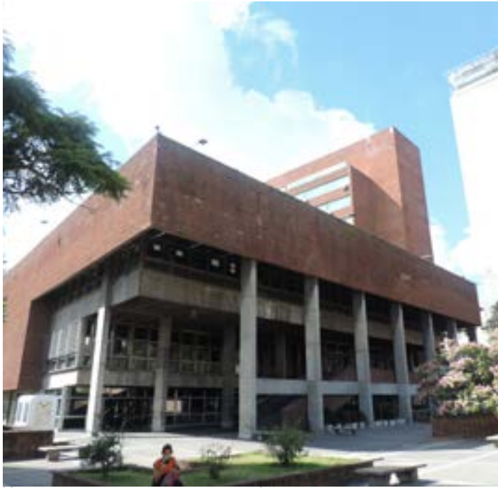
IMG 77. Fotografía tomada desde la esquina de Fernández Crespo y Mercedes. En primer plano el volumen bajo con su materialidad en hormigón, ladrillo y aberturas en acero inoxidable. Se percibe el espacio intermedio y su relación con el ámbito urbano. Fotografía Enrique Castro.
