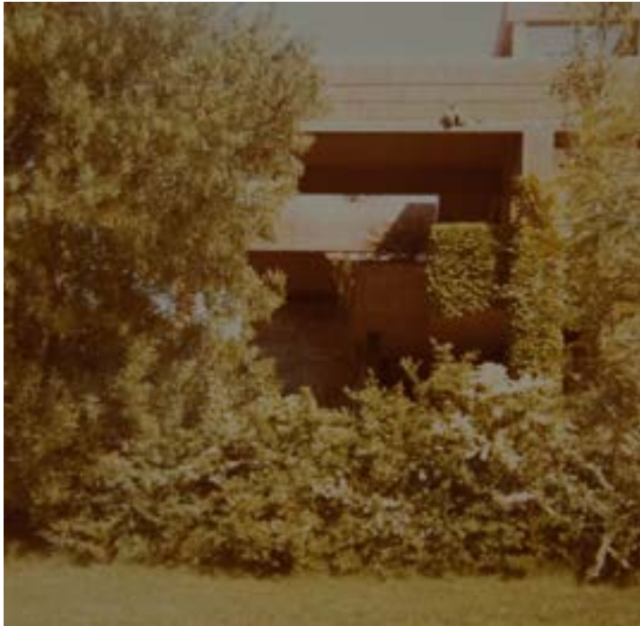
IMG 124. Fotografía vivienda Payssé tomada desde el norte ubicado en la plaza con la ventana en el cerco vegetal en la proyección del espacio intermedio. Naturaleza y Arquitectura se funden en una unidad. Fotografía archivo familiar. Marcelo Payssé. Caja Carrasco IHA FADU UDELAR
