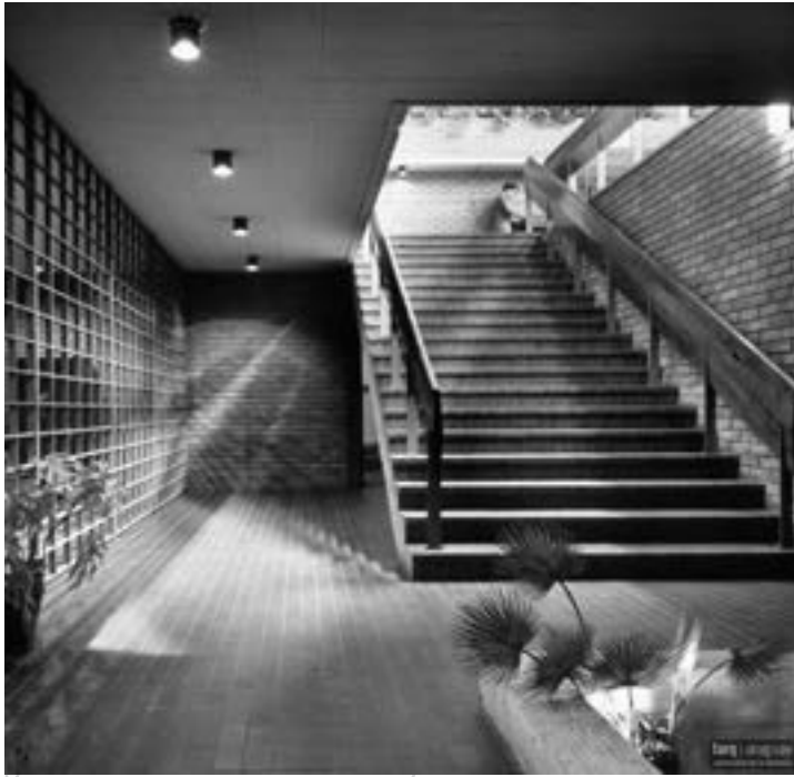
IMG 99. Fotografía del acceso sobre la Calle Marcelino Sosa. Fotografía J. Shulman 1967. SMA FADU imagen 45817.jpg
