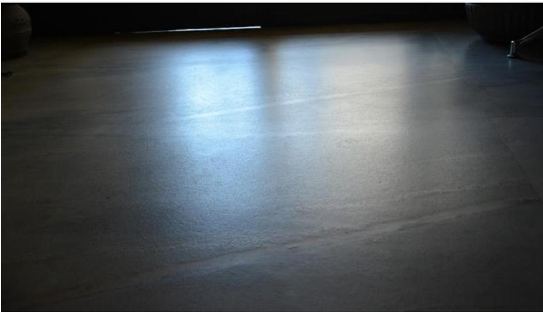
*Fig. 44. Erosión diferencial en respuesta a la menor resistencia a la abrasión que presentan los niveles blancos del Mármol Gris N respecto a su matriz color gris perla. Aplicación en piso interior, hall de entrada del Edificio Danubio, Calle Paraguay 1547.*
