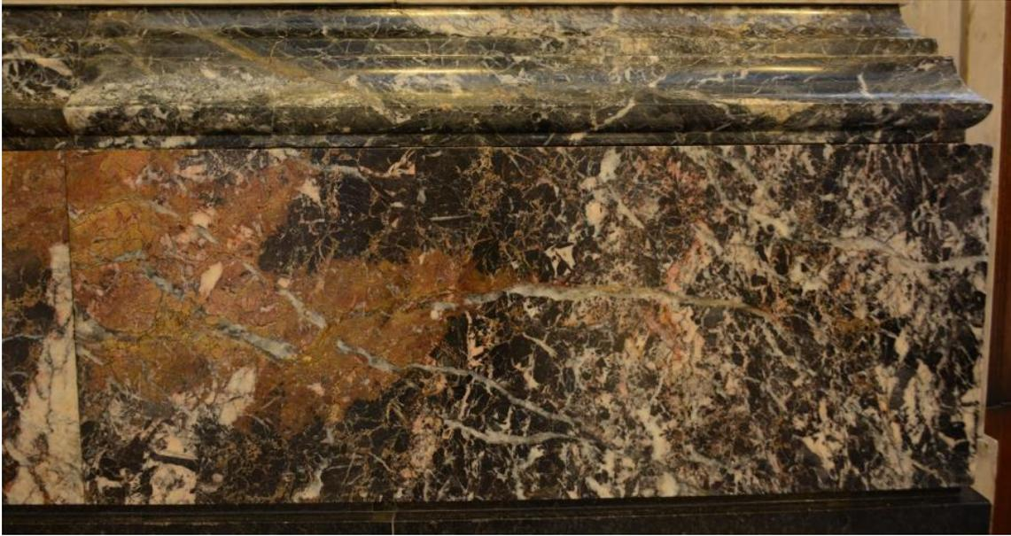
*Fig. 36. Placa de revestimiento de pared en Mármol Negro Charrúa. Dimensiones de la placa: 100 cm x 40 cm. Encontrado en el Palacio Legislativo, Av. de las Leyes.*
