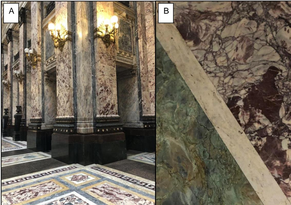
*Fig. 5. Revestimiento interior del Salón de los Pasos Perdidos del Palacio Legislativo de Montevideo. A- Columnas y alfombra de piedra que combinan mármol de Nueva Carrara y otras variedades nacionales de mármol. B- Foto en detalle de Mármol de Nueva Carrara (superior derecha) y Mármol Verde de Nueva Carrara (inferior izquierda).*
