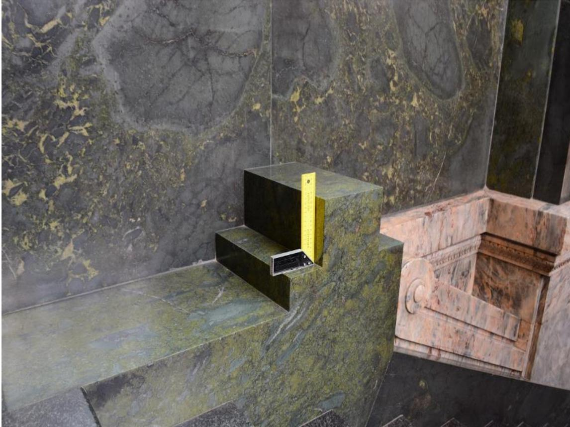
*Fig. 35. Placas de revestimiento de pared, y bloques, de Mármol Verde. Escala: escuadra de dimensiones 20 cm x 10 cm. Encontrado en el Palacio Legislativo, Av. de las Leyes.*
