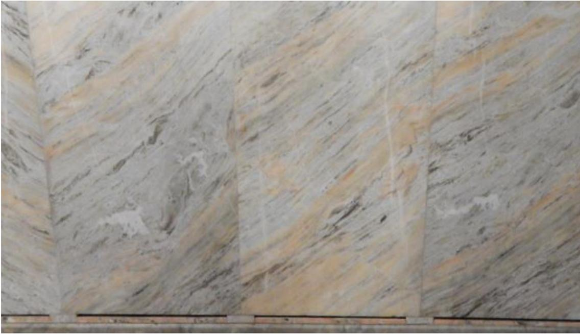
*Fig. 19. Placas de revestimiento de paredes interiores en Mármol Maciel. Dimensiones de las placas: 120 cm x 50 cm. Encontrado en la Catedral metropolitana de Montevideo, Ituzaingó 1373, Plaza Matriz.*
