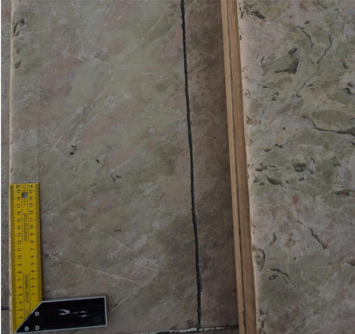
*Fig. 39. Escalón en Mármol Amarillo de Minas. Escala: escuadra de dimensiones 20 cm x 10 cm. Encontrado en escalinata de Facultad de Arquitectura Diseño y Urbanismo, Bulevar General Artigas 1031.*
