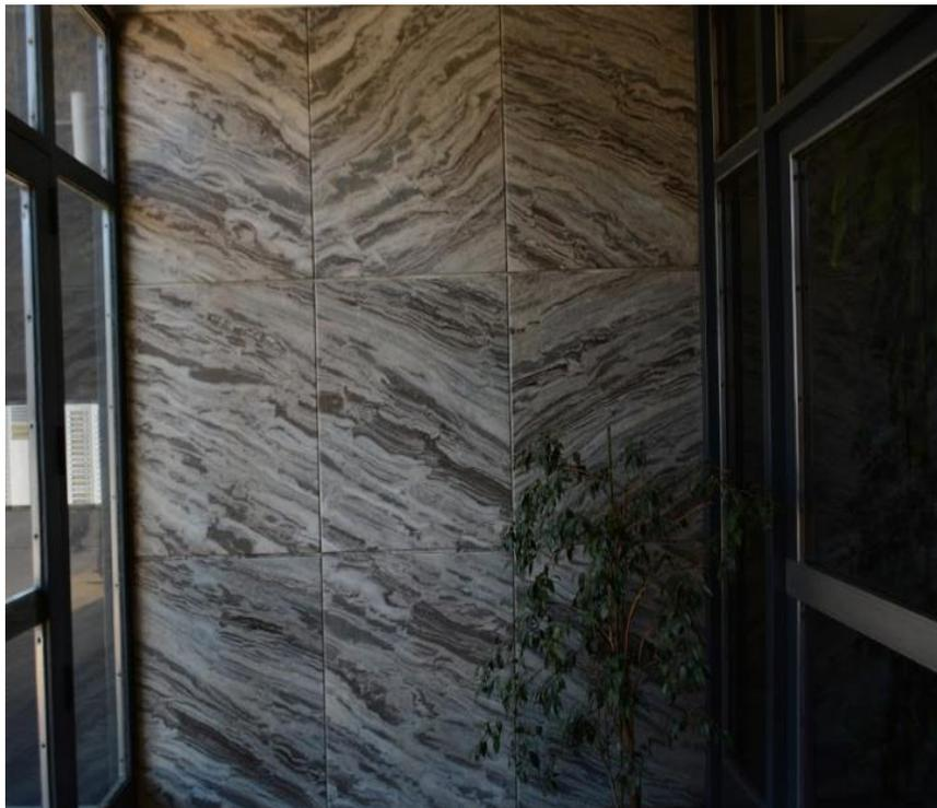
*Fig. 21. Placas de revestimiento de pared interior en Mármol Abayubá. Dimensiones de las placas: 100 cm x 50 cm. Encontrado en el Edificio Danubio, Paraguay1547*
