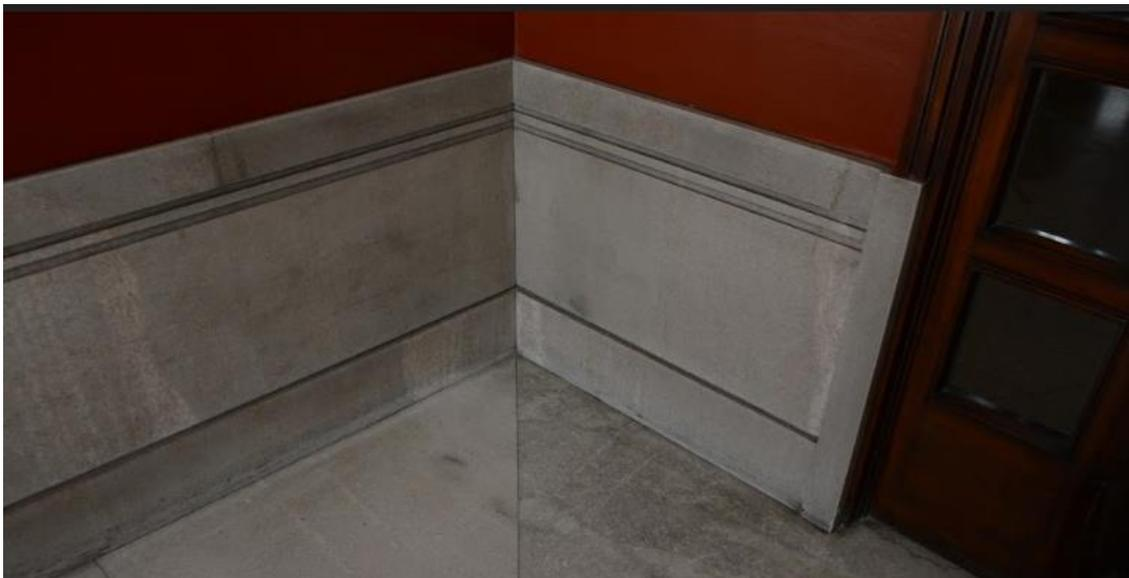
*Fig. 24. Placas de revestimiento de pared y piso en Mármol Gris N. Dimensiones de las placas: 100 cm x 50 cm. Encontrado en el Edificio 14 de Mayo, Av del Libertador Brig. Gral Juan Antonio Lavalleja 1470.*
