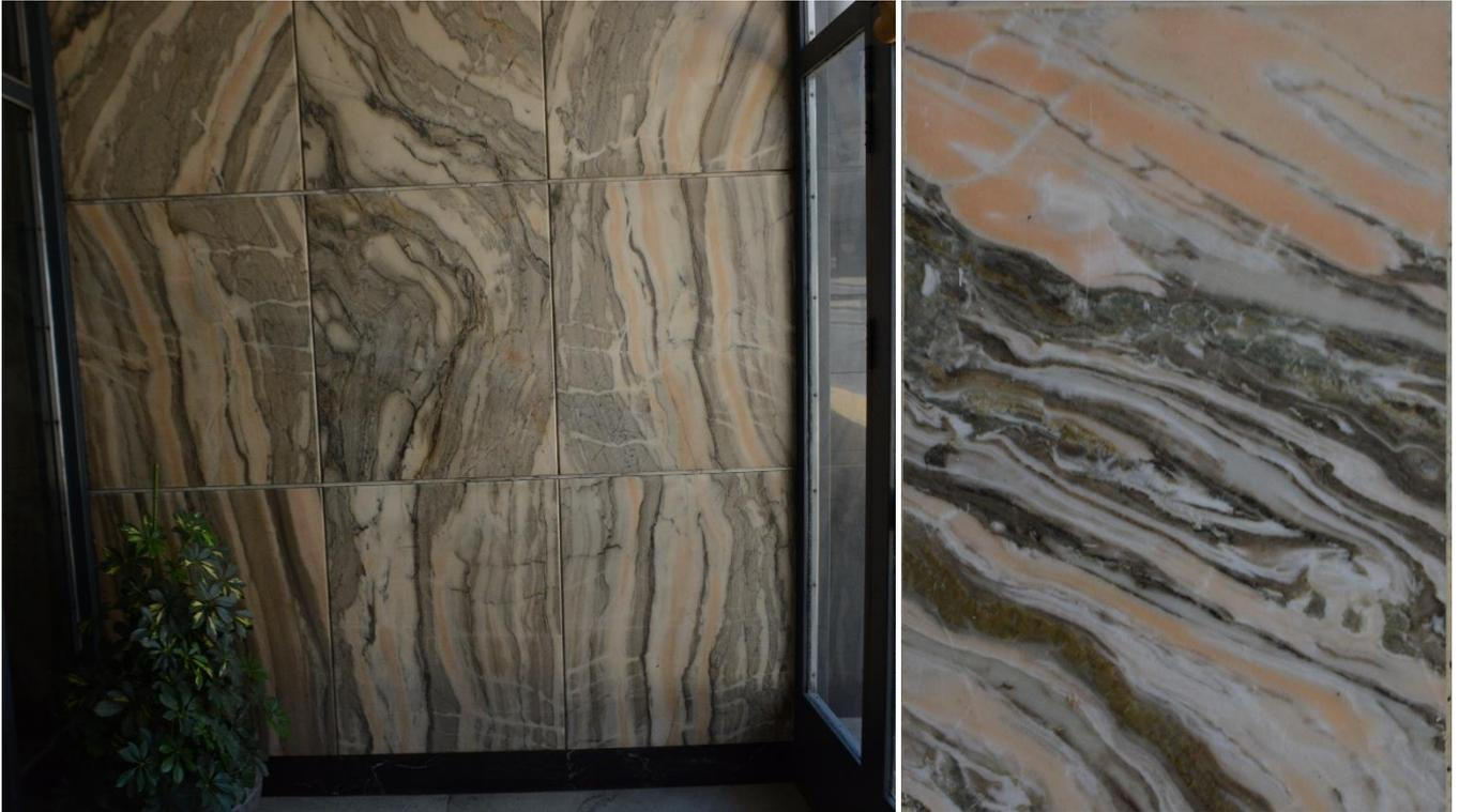
*Fig. 60. Similitud de decores. Izquierda - Placas de revestimiento de pared de dimensiones 100 cm x 50 cm; Edificio Danubio, Calle Paraguay 1547. Derecha - Variación del décor en una placa de revestimiento de piso en Mármol Artigas, dimensiones 60 cm x 40 cm; Palacio Brasil, Av. 18 de Julio 990.*
