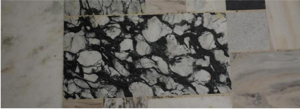
*Fig. 20. Placa de revestimiento de piso de mármol san martín (centro de la foto). Dimensiones de la placa 60 cm x 30 cm. Encontrado en el Palacio Brasil, Av. 18 de Julio 994.*
