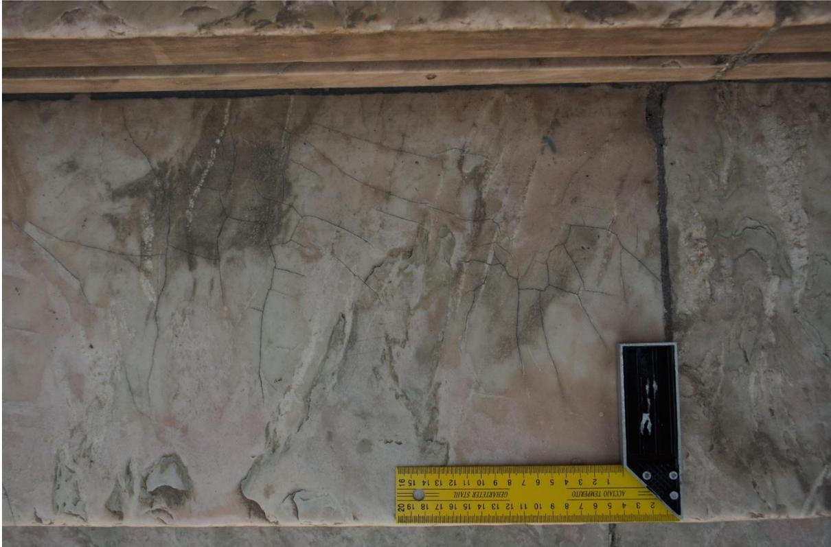
*Fig. 45. Craquelado desarrollado por el Mármol Amarillo de Minas. Escalinatas exteriores de la Facultad de Arquitectura Diseño y Urbanismo, Bulevar General Artigas 1031. Escala: escuadra de 20 cm x 10 cm.*
