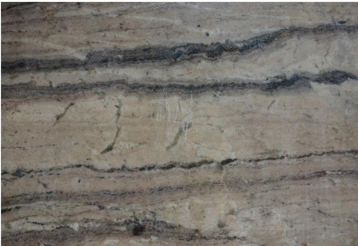
*Fig. 38. Placa de revestimiento de pared en Mármol Travertino Marrón. Dimensiones de la placa: 40 cm x 30 cm. Encontrado en Calle San José esquina Wilson Ferreira Aldunate.*
