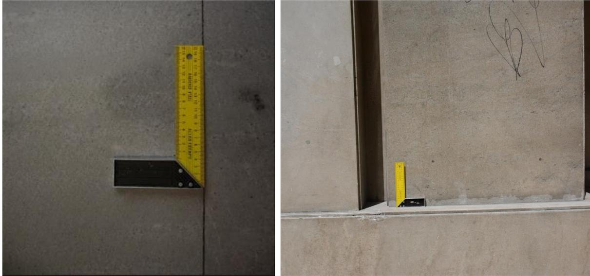
*Fig. 43. Decoloración del Mármol Gris N en el Edificio 14 de Mayo. Av del Libertador Brig. Gral Juan Antonio Lavalleja 1470. Izquierda - Aplicación interior. Derecha - Aplicación exterior. Escala: escuadra de 20 cm x 10 cm.*
