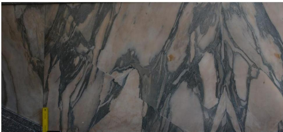
*Fig. 34. Placas de revestimiento de pared en Mármol Verde Salus. Dimensiones de las placas: 100 cm x 80 cm. Encontrado en el Palacio Legislativo, Av. de las Leyes.*
