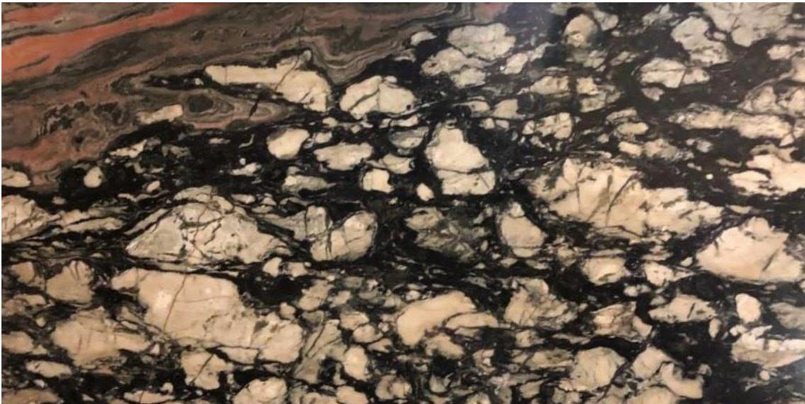
*Fig. 7. Placa de mármol de 50x100 cm. Revestimiento de pared interior, Palacio Salvo, Montevideo. Se observa el pasaje entre las variedades Artigas (Superior izquierda) y San Martín.*
