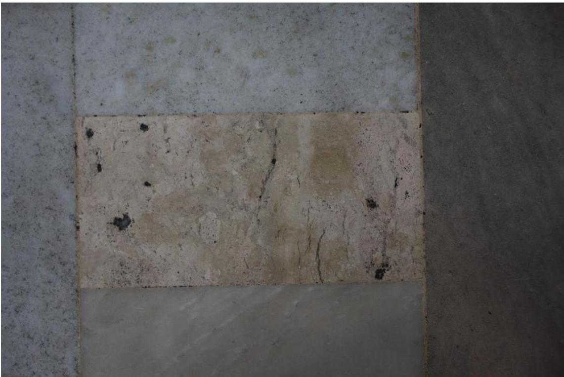
*Fig. 37. Placa de revestimiento de piso en Mármol Travertino (centro de la imagen). Dimensiones de la placa: 30 cm x 10 cm. Encontrado en Palacio Brasil, Av. 18 de Julio 994.*
