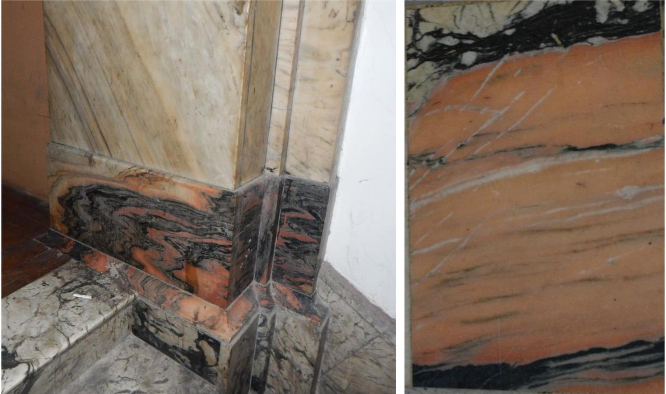
*Fig. 61. Placas donde se observa el contacto entre variedades comerciales conocidas de mármoles nacionales. Izquierda – Zócalo elaborado en Mármol Artigas donde se evidencia el contacto de este con el Mármol Maciel; Primer piso del Palacio Salvo, Plaza Independencia 848. Derecha – Placa de revestimiento de piso en Mármol Artigas que muestra el contacto de este con el Mármol San Martín; Palacio Brasil, Av. 18 de Julio 990.*
