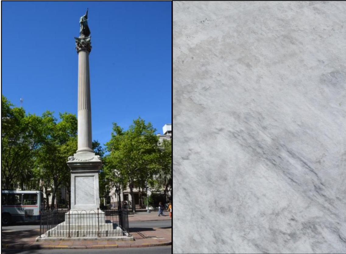
*Fig. 6. Escultura de la conciliación, Plaza Cagancha de Montevideo. Izquierda- Vista general del monumento. Derecha- Vista en detalle del mármol Gris N empleado para el fuste de la escultura.*
