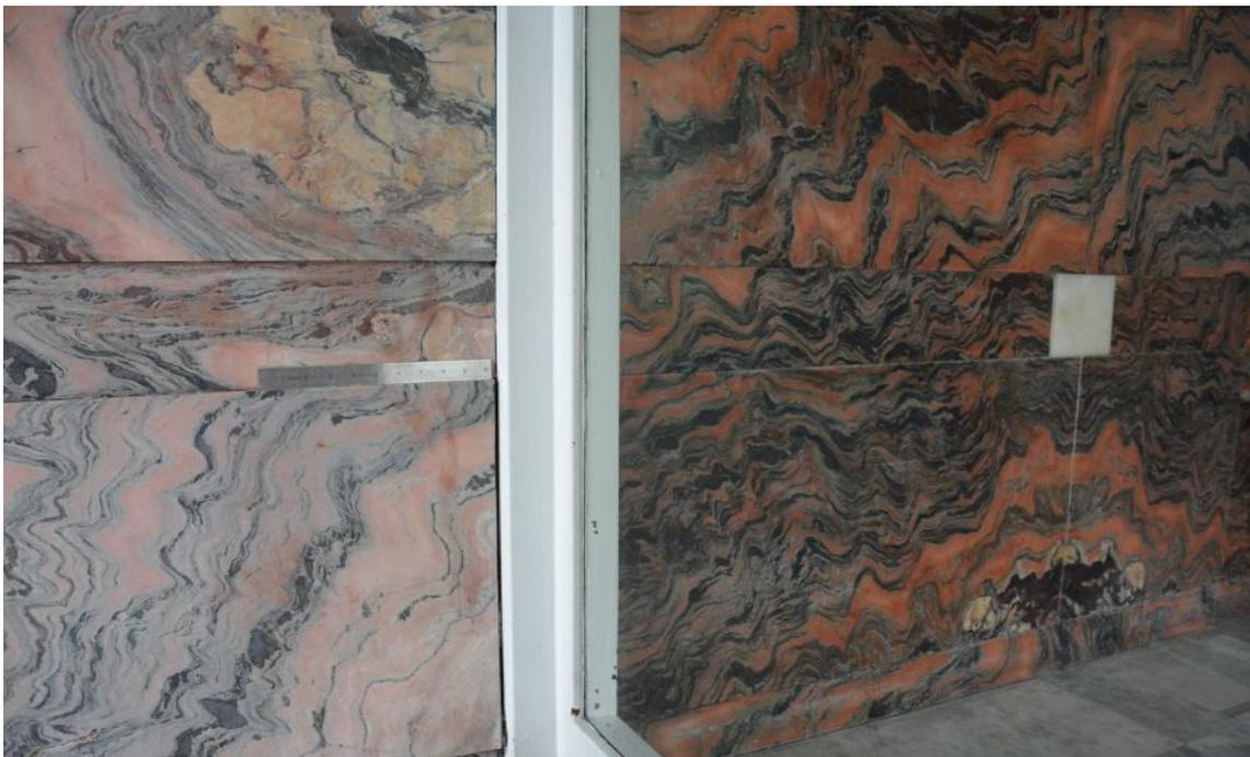
*Fig. 40. Diferencia de coloración en placas de revestimiento de pared de mármol Artigas, exterior (izquierda) e interior (derecha), evidenciando decoloración de las placas expuestas a la intemperie. Aplicación encontrada en el edificio ubicado en Calle Ellauri 697 esquina Solano Antuña. Escala: 25 cm.*
