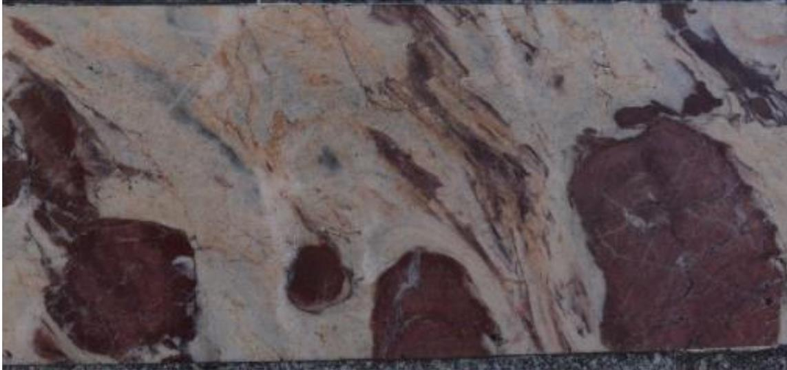
*Fig. 33. Placa de revestimiento de piso en Mármol Nueva Carrara. Dimensiones de la placa: 80 cm x 30 cm. Encontrado en el Palacio Legislativo, Av. de las Leyes.*
