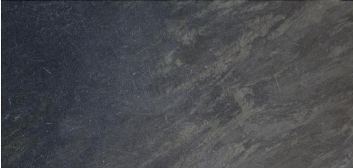
*Fig. 59. Variación inédita del décor del Mármol Negro Tamara en placa de revestimiento de piso interior. Encontrado en Palacio Brasil, Av. 18 de Julio 990. Dimensiones de la placa: 50cm x 25cm.*
