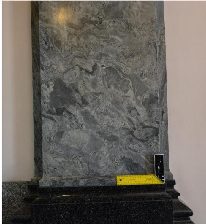
*Fig. 56. Columna labrada en una sola pieza de mármol de décor inédito. Encontrada en el vestíbulo Norte del Palacio Legislativo de Montevideo, Av. De las Leyes. Escala: escuadra de 20cm x 10cm.*
