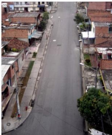
Imagen 33: Calle 107 estado previo a la intervención en primer piso. PUI Nororiental. Fuente: EDU, 2004.
