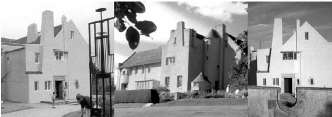
Reconocimiento exterior y distribución planimétrica de la vivienda
