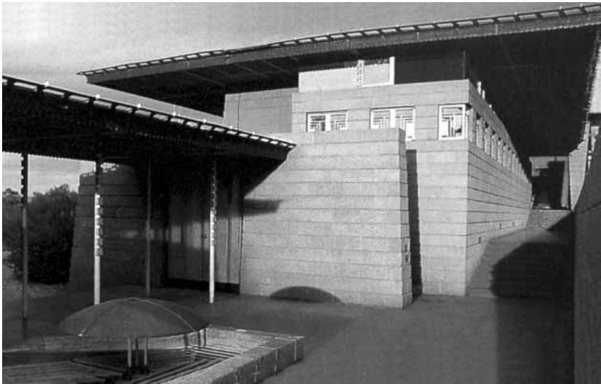
Secuencia de aproximación e ingreso: el portón, la gran explanada y el patio de acceso
