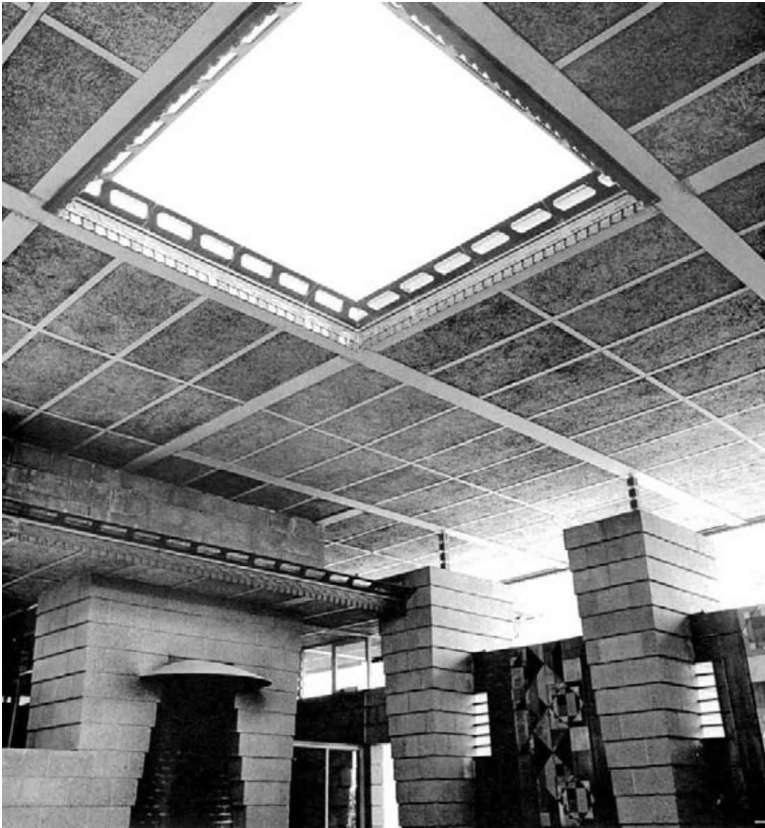
El espacio ventilado y en sombra del atrio como respuesta natural a la aridez del desierto
