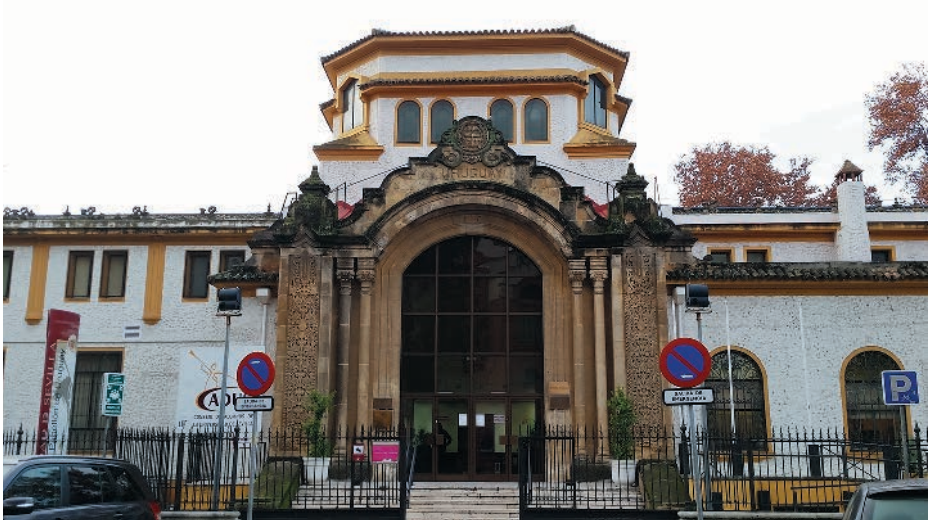
FIGURA 8. MAURICIO CRAVOTTO: PABELLÓN DE URUGUAY EN LA EXPOSICIÓN IBEROAMERICANA DE SEVILLA. ESTADO DE LA CONSTRUCCIÓN EN 2017.
