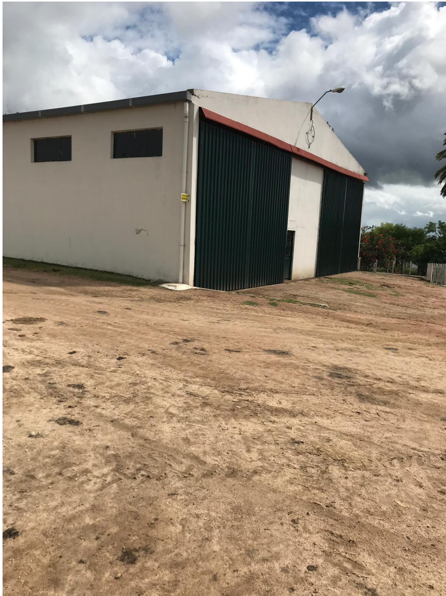
Figura 6 Galpón para almacenaje de insumos.
