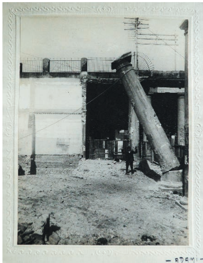
FIGURA 1. DEMOLICIÓN DE LA CONFITERÍA LA GIRALDA. SE VE EL INSTANTE EN QUE COMIENZA A CAER UNA DE LAS COLUMNAS DÓRICAS DE LA PASIVA. MONTEVIDEO (CA. MARZO DE 1922).
